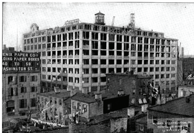
< The Robert Gair Co., bâtiment d'illustration choisi par Le Corbusier pour le rappel «La Surface», The Atlas Portland Cement Company, New York, 1907, Collection of The Skyscraper Museum.
