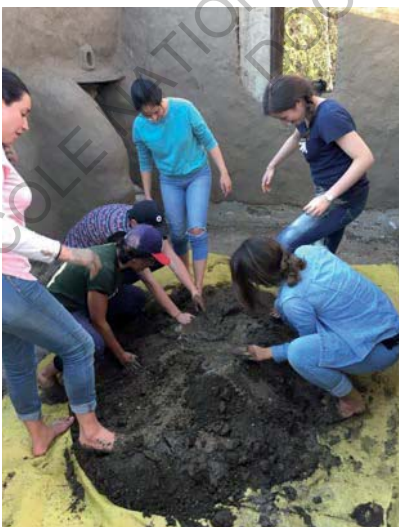
Fig. 33 à 35 - Mis en œuvre de la bauge à l'ITT
