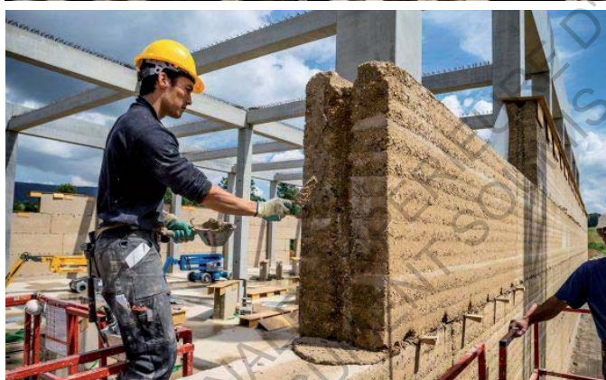
Fig. 77 à 80 - Pisé préfabriqué, Ricola Center, Martin Rauch
