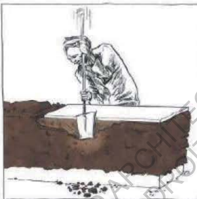
LES DEUX FACES DU MUR SONT TAILLÉES À L'AIDE D'UNE SÈCHE OU D'UN OUTIL TRANCHANT.
