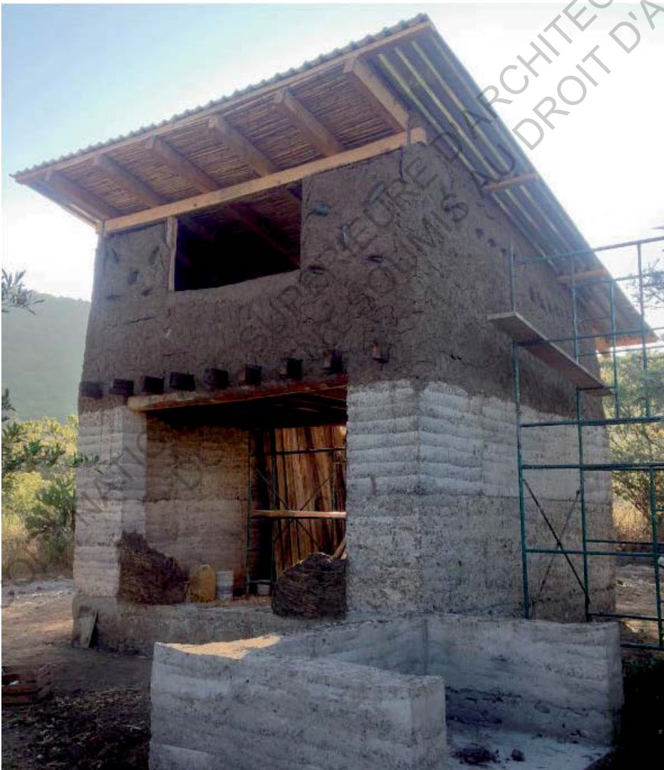
Fig. 67 - Module d'habitation en construction à l'ITT
