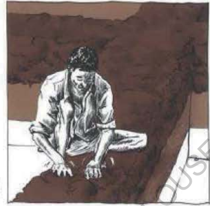
LES PAIQUES SONT EMPILÉES SUR LE COUFORMENT PAR COUCHES D'ENVIRON 50 À 60 CM DE HAUTEUR. ELLES SONT SOUVENT DÉPOSÉES LES UNES SUR LES AUTRES POUR UNE MEILLEURE COHÉSION.
