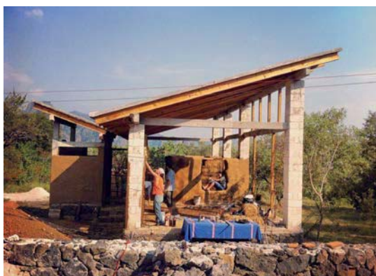
Fig. 45 et 46 - Murs en remplissage en bottes de paille, chantiers participatifs
