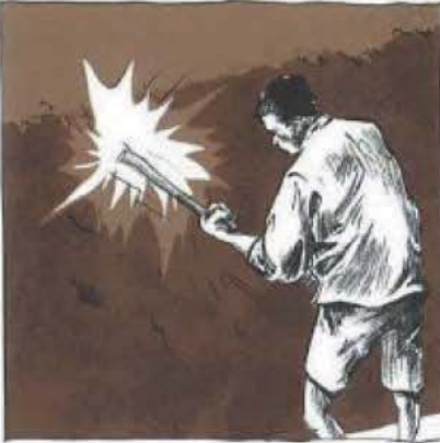
CHAQUE COUCHE EST BATTUE POUR REFERMER LES FISSURES ÉVENTUELLEMENT APPARUES LORS DU SÉCHAGE, QUI DURE ENVIRON DEUX SEMAINES.
