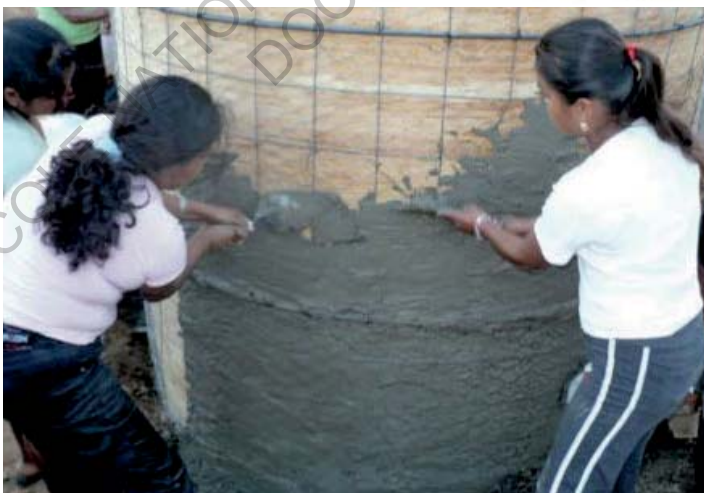
Fig. 52 à 54 - Réalisation d'une citerne de « ferrocemento »
