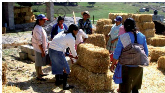
Fig. 45 et 46 - Murs en remplissage en bottes de paille, chantiers participatifs
