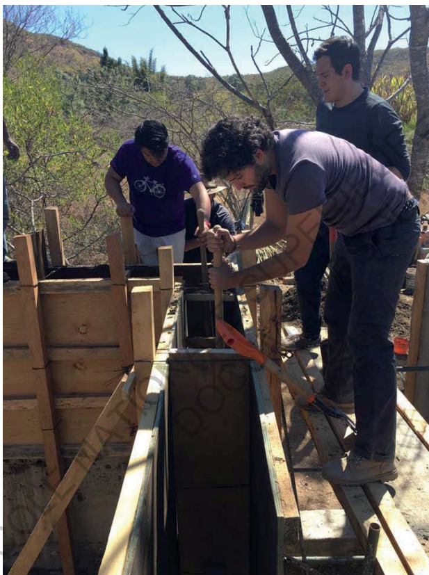
Fig. 38 et 39 - Mis en œuvre du pisé à l'ITT
