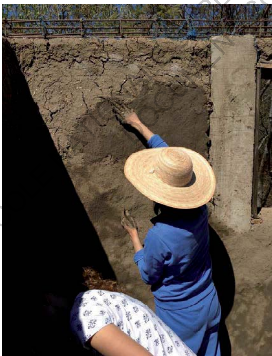
Fig. 30 et 31 - Mis en œuvre du torchis à l'ITT
