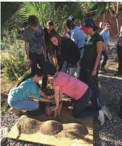
Fig. 41 et 42 - Mis en œuvre de l'adobe à l'ITT
