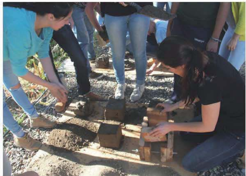
LES ADOBES SONT MAÇONNÉES À L'AIDE D'UN MORTIER DE TERRE SUR UN SOUBASSEMENT (PIERRES, BRIQUES DE TERRE CUITE...)
