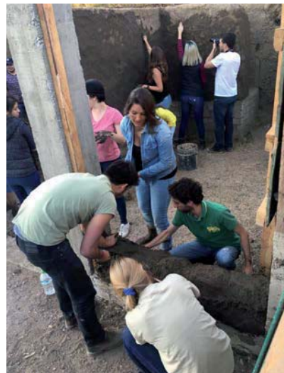
Fig. 33 à 35 - Mis en œuvre de la bauge à l'ITT
