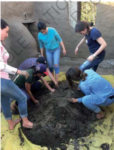
Fig. 33 à 35 - Mis en œuvre de la bauge à l'ITT
