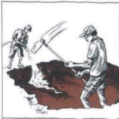
LA TERRE EST MALAXÉE JUSQU'À ATTEINDRE L'ÉTAT PLASTIQUE (15 À 30 % D'EAU).
