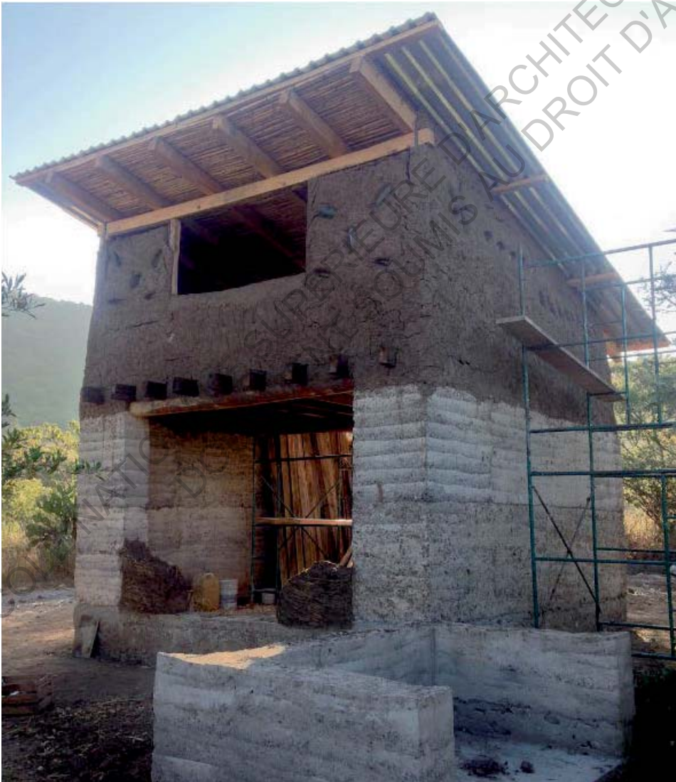
Fig. 67 - Module d'habitation en construction à l'ITT
