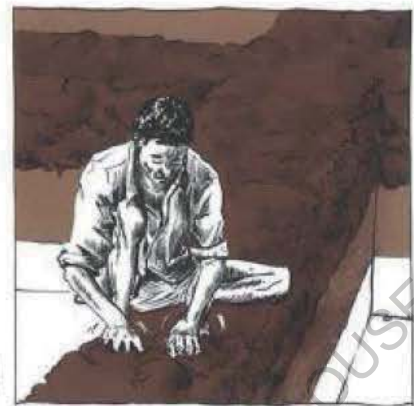
LES PAIQUES SONT EMPILÉES SUR LE COUVRASSEMENT PAR COUCHES D'ENVIRON 50 À 60 CM DE HAUTEUR. ELLES SONT SOUVENT DÉPOSÉES LES UNES SUR LES AUTRES POUR UNE MEILLEURE COHÉSION.
