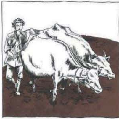
LA TERRE, SOUVENT EXTRAITE DU SITE, EST MALAXÉE À L'ÉTAT PLASTIQUE (15 À 30 % D'EAU). ICI, ELLE A ÉTÉ ADDITIONNÉE DE PAILLE DE RIZ ET MALAXÉE PAR DES BOUFFES.
