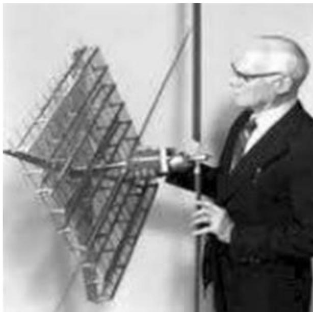
*Figure 3: W.C. BROWN présente son hélicoptère avec l'antenne rectificatrice*
