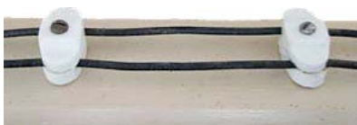
Figure 46: Exemple de cheminement en fils parallèles de 1925.
