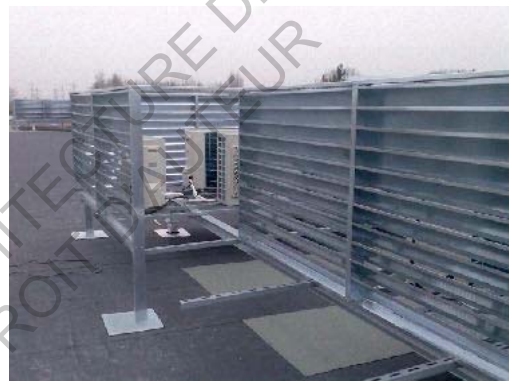
Figure 92: Brise vue et sonore groupe froid en toiture.
