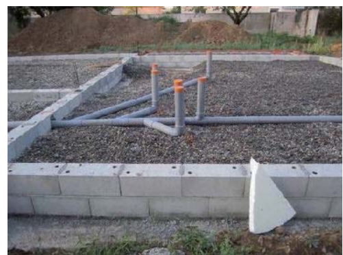
Figure 76: Evacuation PVC dans vide sanitaire.
