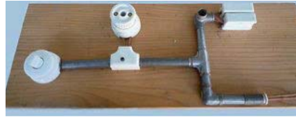
Figure 50: Installation avec tube Bergman avec éléments en porcelaine de 1925.
