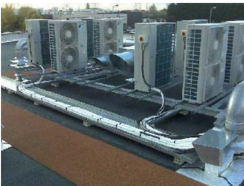
Figure 91: Installation groupe froid en toiture.
