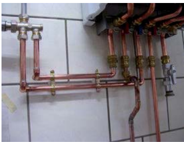
Figure 69: Installation chauffe eau au gaz avec tube de cuivre.
