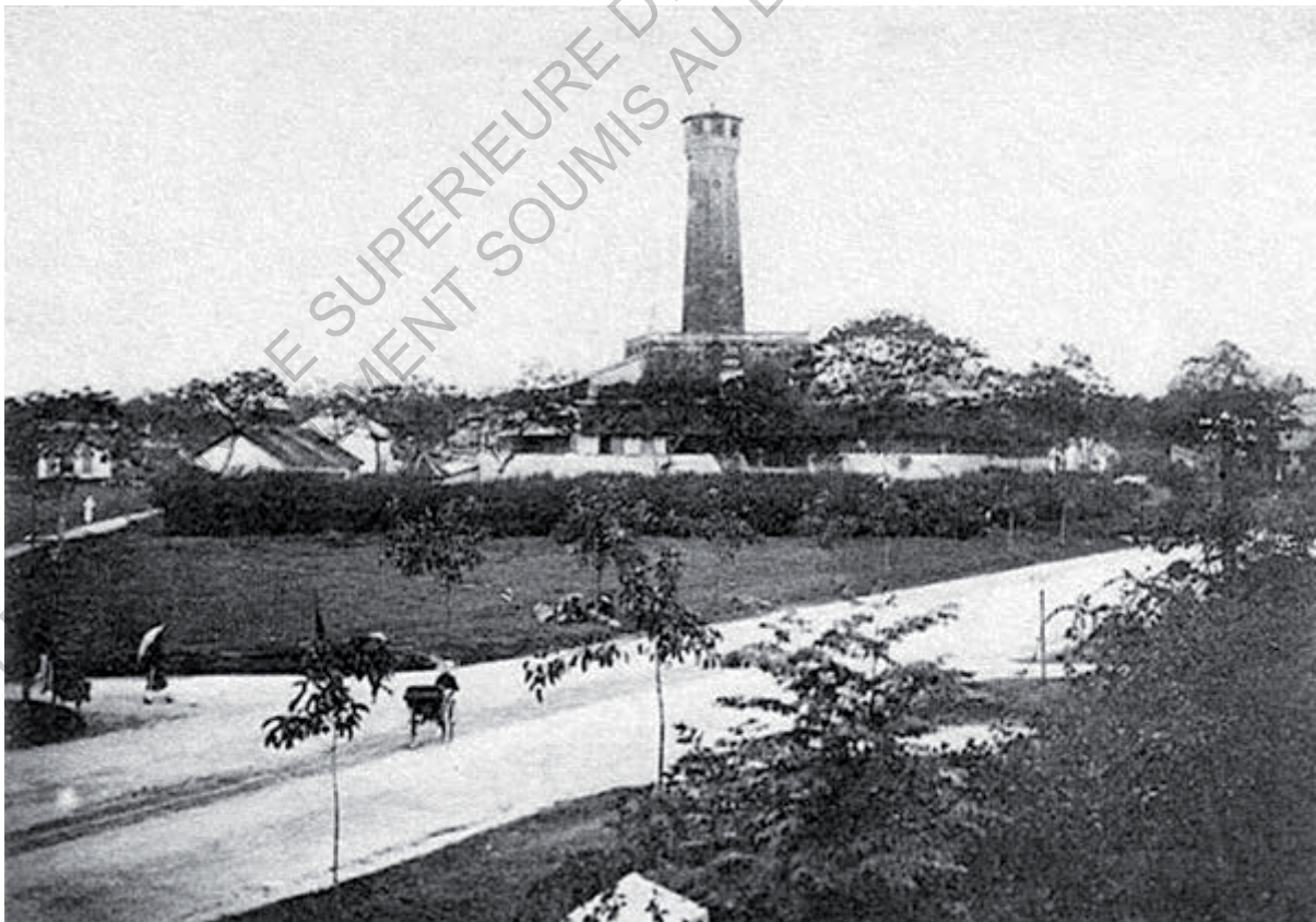
4. Photographie des abords de la Citadelle sur la rue Tran Phu (ancien boulevard Felix Faure), après la démolition des remparts et la plantation des arbres. Source internet
