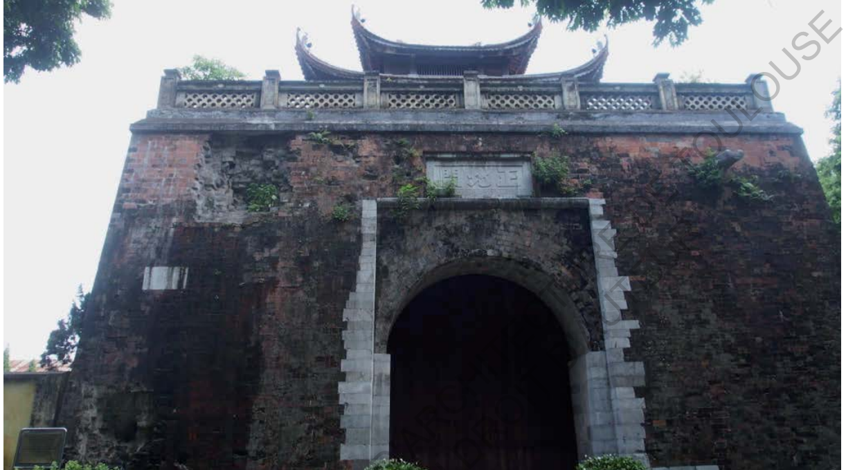
Porte nord Cua Bac de la Citadelle d'Hanoi et ses impacts de boulets de canons
