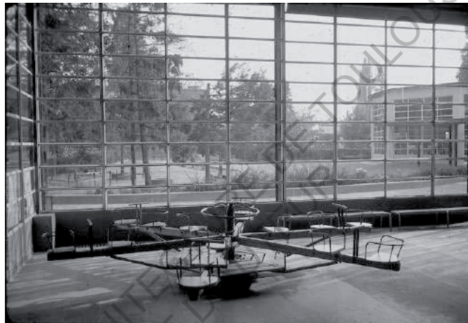
Vue intérieure de la salle de jeux. Ecole de plein-air de Suresnes. Cliché anonyme. 1935. Cité de Chaillot
