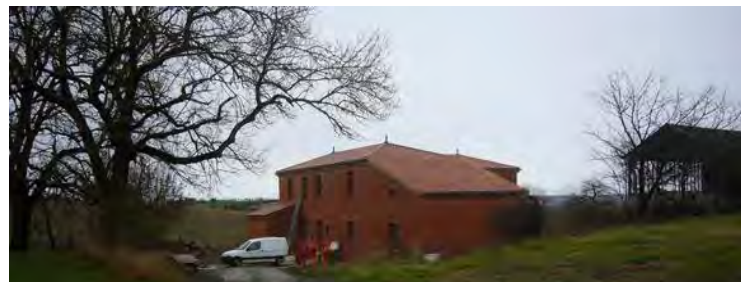
Architecture vernaculaire Gersoise : Tentative d'auto-construction bioclimatique respectueuse des codes régionaux
