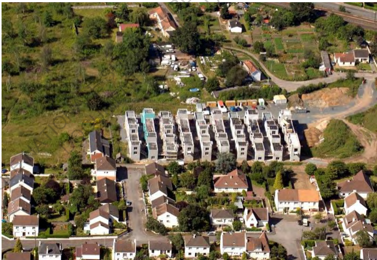
Photographie aérienne de l'îlot 1 (à droite) et 2 (à gauche) Boskop après leur construction
