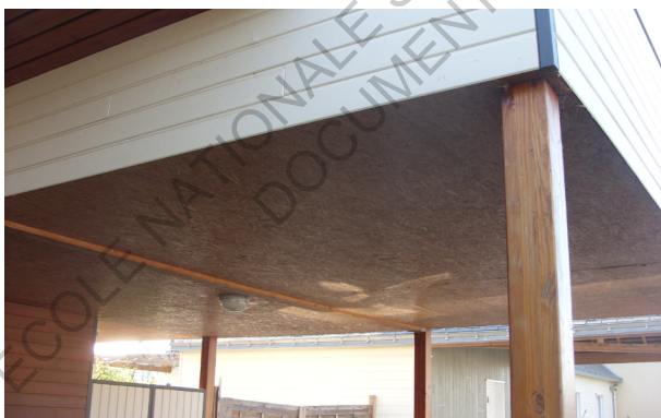
Maison individuelle au Lion d'Angers (49) Maître d'Oeuvre : AD construction Bardage : lames peintes à système rainure et languette Sous-face : panneaux OSB Source : photographie personnelle
