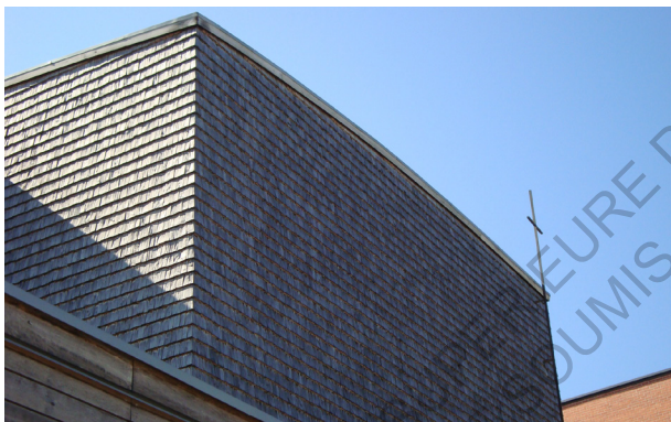
Église de Viikki (Finlande) Architecte : JKMM Architects Vêtue : bardeaux de bois Source : photographie personnelle
