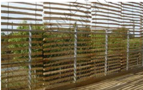
Hôtel d'entreprise à Puceul (44) Architecte : GLV Vêture (double-peau) : Ganivelles de châtaigner Source : www.glvarchitectes.com
