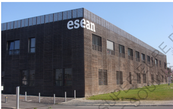
Établissement de santé ESEAN à Nantes (44) Architecte : Brunet-Saunier Vêture : bardage à claire-voie Source : photographie personnelle
