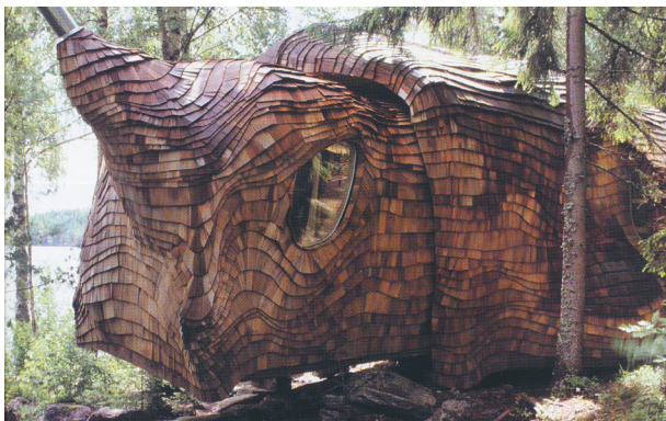
Maison de vacances au lac Övre Gla (Suède) Architectes : M.Lammers et B.Zeisser Vêtue : Bardeaux de bois Source : « Architecture à vivre » n°21 (nov/dec 2004)
