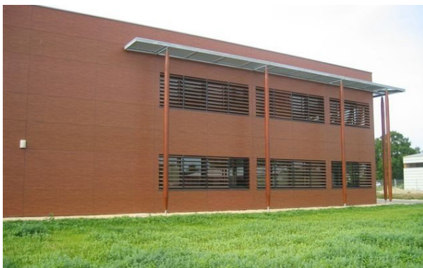
Bâtiment de bureaux à La Ferrière (85) Architecte : BMZ sarl Vêtire : panneaux de synthèse Source : CNDB
