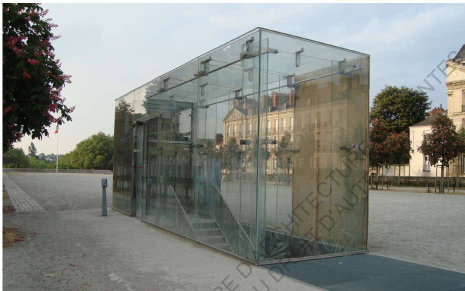
Fig. 3 Edicule sur le cours Saint André (entrée et sortie piétonne)
