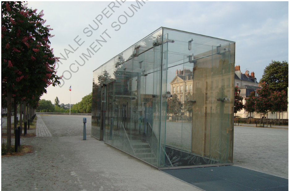
Fig. 4 Entrée piétonne du parking Cathédrale (Cours Saint André)
