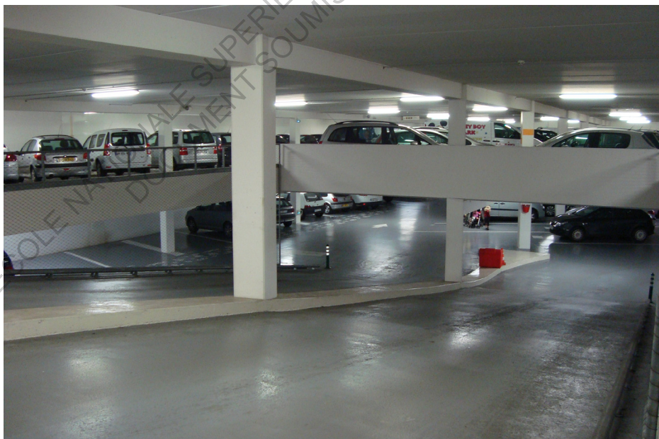
Fig. 4 Rampe reliant le niveau -1 au niveau -2
