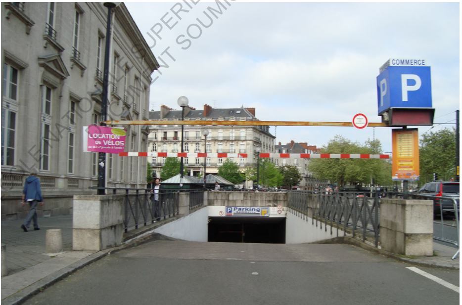
Fig. 2 Entrée du parking Commerce (Allée de la Bourse)
