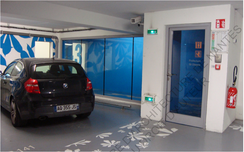
Fig. 9 Sas amenant aux escaliers (niveau -3)
