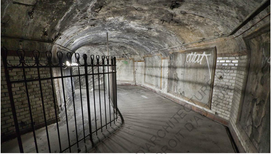
Fig. 1 Un ancien couloir de métro à Paris, laissé en l'état à sa fermeture en 1939
