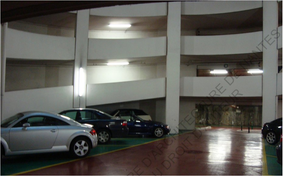
Fig. 7 Allée centrale du niveau -7
