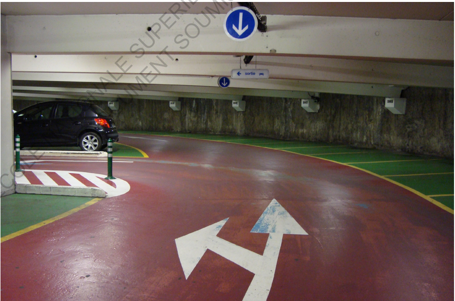
Fig. 10 Allée centrale du niveau -3
