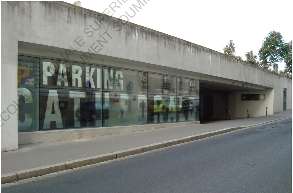
Fig. 2 Entrée du parking cathédrale (rue Tournefort)
