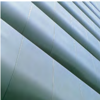
Détail du revêtement de la façade du Baron vert
