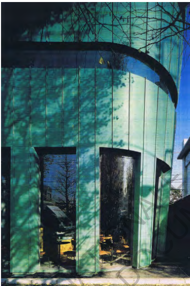
La façade est revêtue de panneaux métalliques striés.
