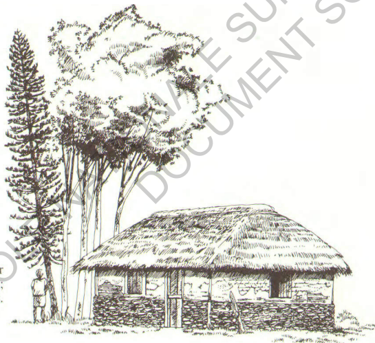
3. Maison à murs de torchis sur soubassement de pierres sèches ; couverture de paille.
