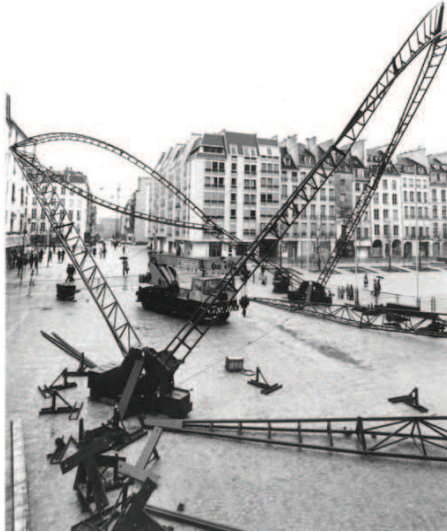
Le Diatope: montage de la structure, mars 1977
