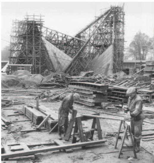
Construction du Pavillon Philips, montage des panneaux préfabriqués
