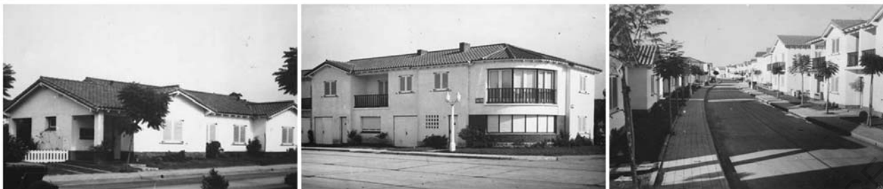
Photographies d'époque des rues résidentielles *
