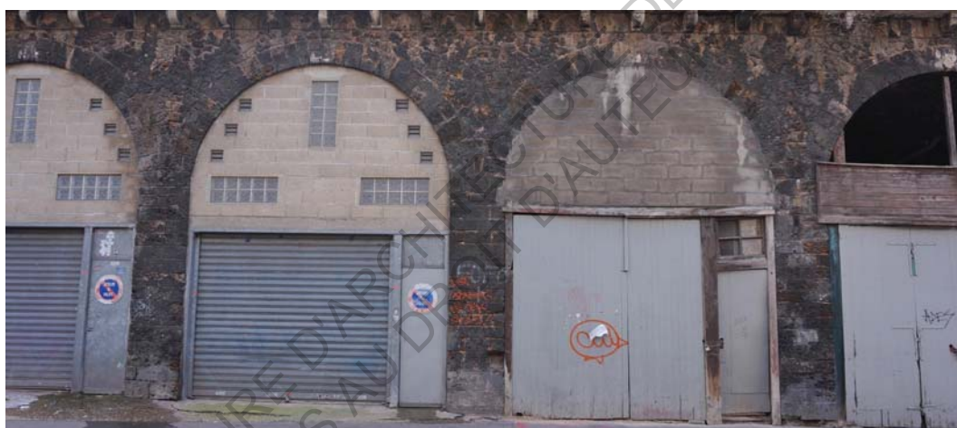
Extensions Sous le viaduc Corentin Cariou
