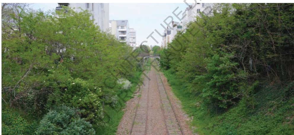
Zone en tranchée Le long de l'Avenue du Général Michel Bizot
