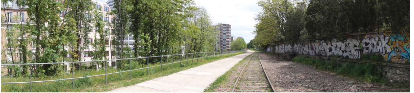
Portion en déblai avec une vue sur la ville dissimulée par la végétation
