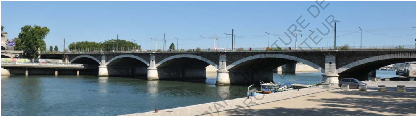
Franchissement de la Seine, vue depuis la rue
