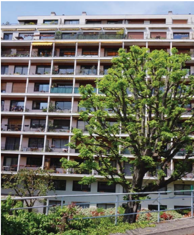
Façade des pièces à vivre Immeuble de la rue Gabon, vue depuis les rails
