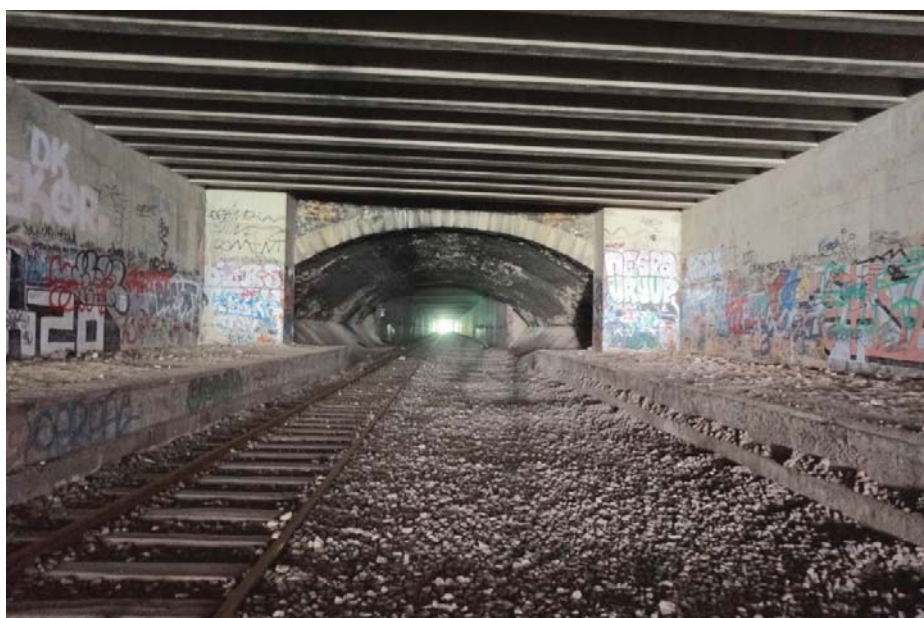
Ancien pont Huguette Schwartz coincé entre deux nouvelles dalles accueillant le jardin de l'Hôpital Broussais
