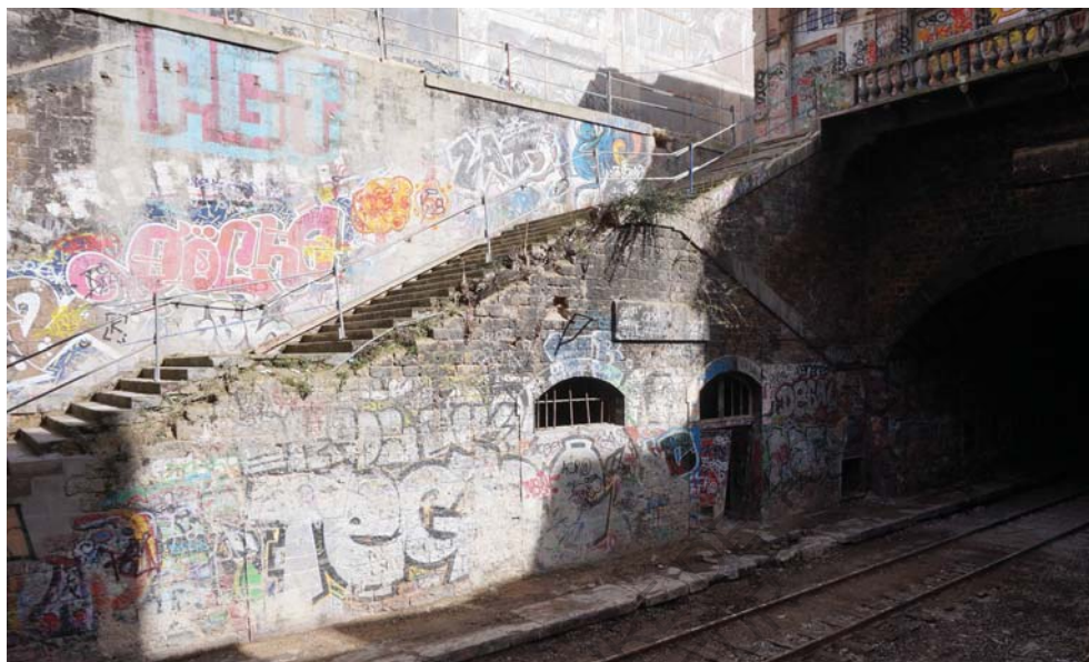
Anciens escaliers de la gare Montrouge
