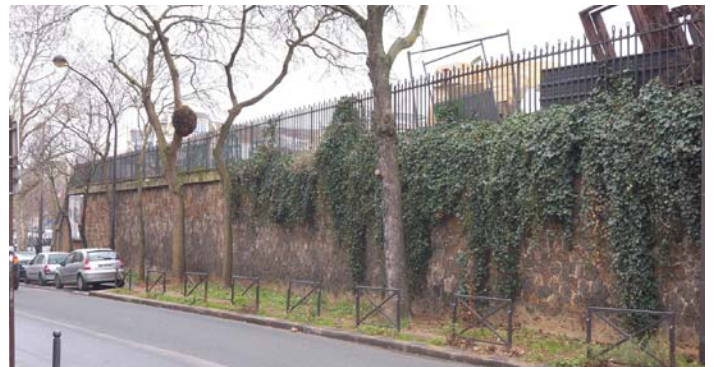
Mur de soutènement Boulevard Montmorency
