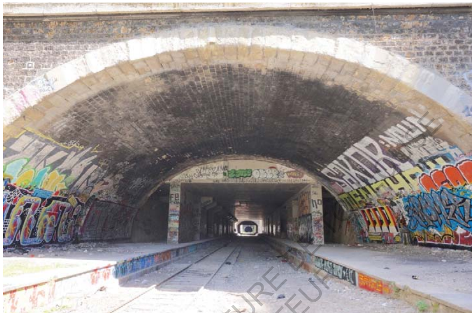
Pont rue Friant, dalle de recouvrement à l'arrière de la gare de Montrouge Dalle accueillant de futurs logements
