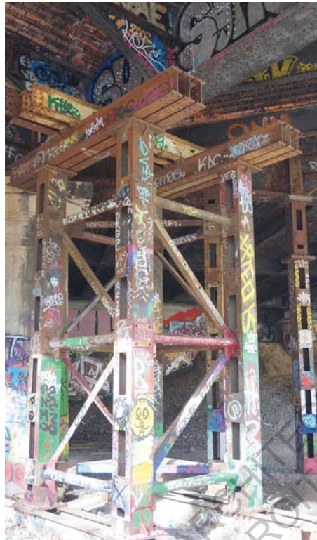
Les infrastructures, Parc Montsouris
