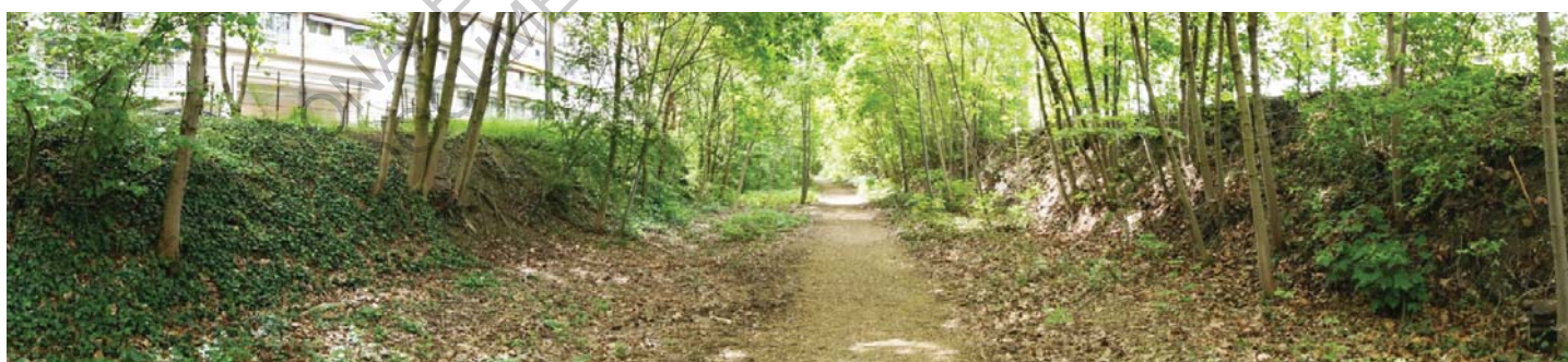
Portion en déblai avec talus
