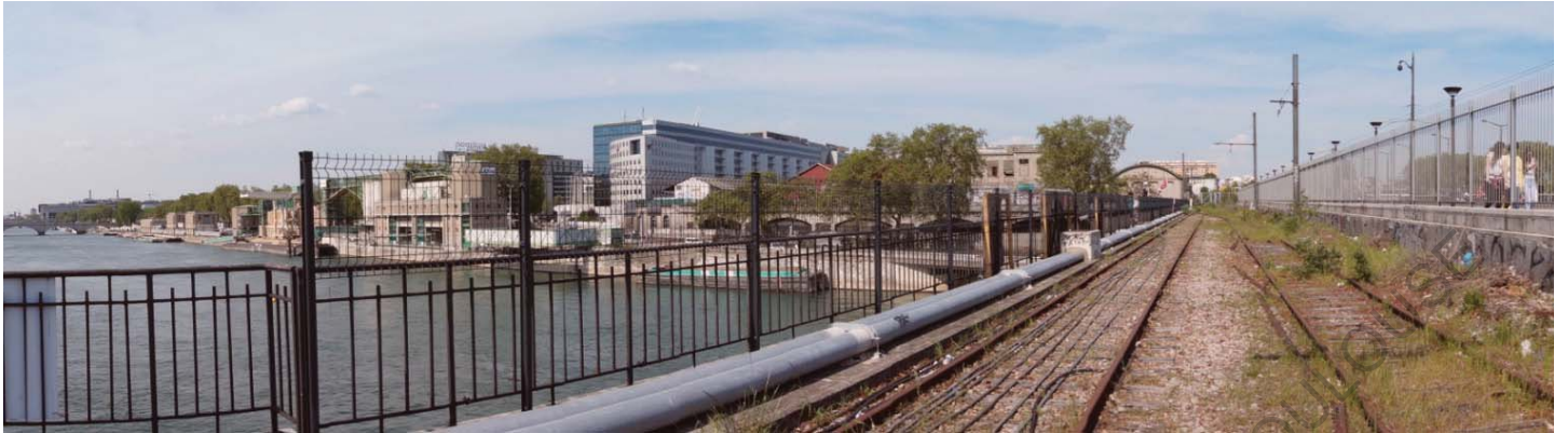
Franchissement de la Seine, vue depuis les rails
