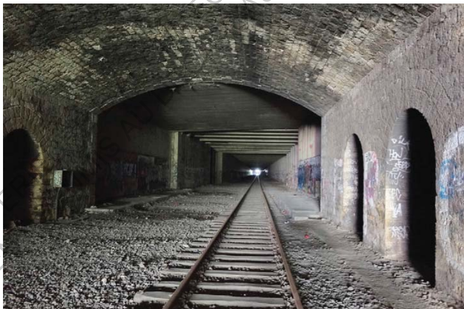
Ancienne et nouvelles tranchées couvertes rue des Longues Rales Dalle accueillant un parking
