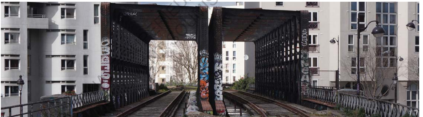
Franchissement du canal d'Ourcq, vue depuis les rails
