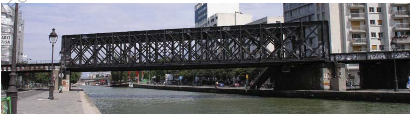
Franchissement du canal d'Ourcq, vue depuis la rue
