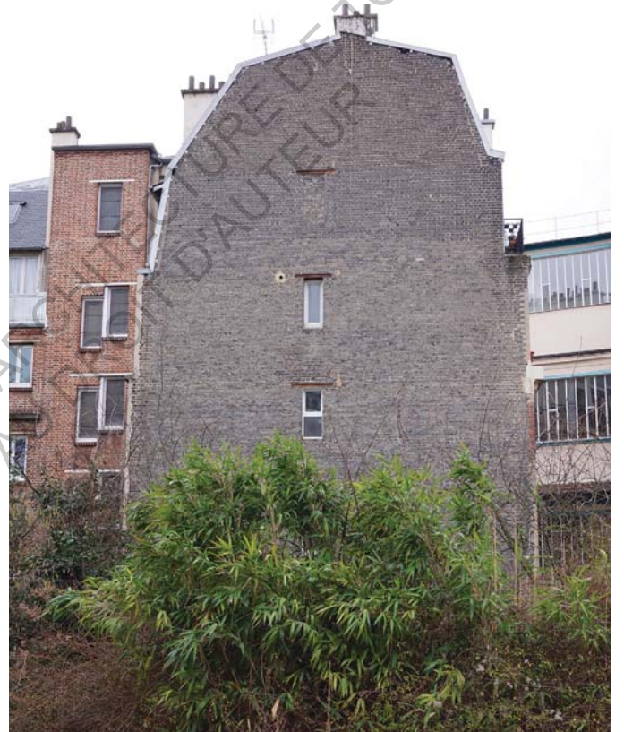
Façade de service Immeuble rue Léon Delagrangé, vue depuis les rails
