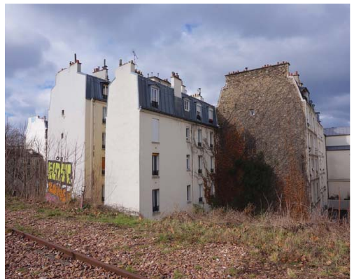
Façade de service Immeuble près de l'Avenue Daumesnil, vue depuis les rails
