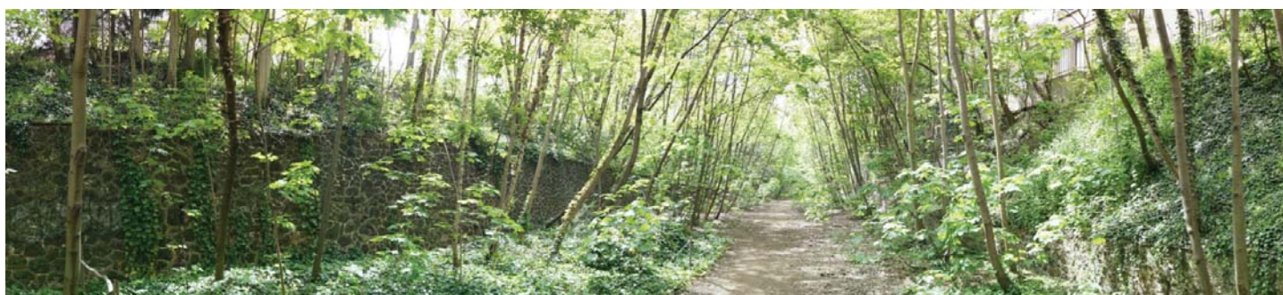
Portion en déblai avec mur de soutènement
