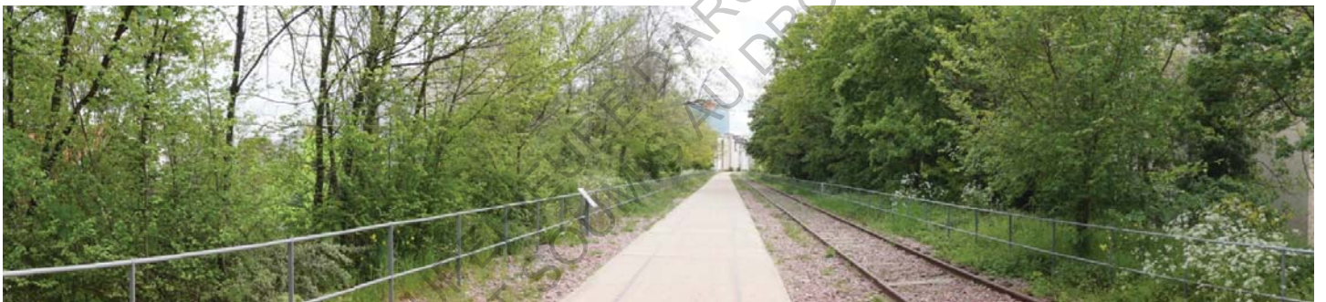
Portion en déblai très végétalisée
