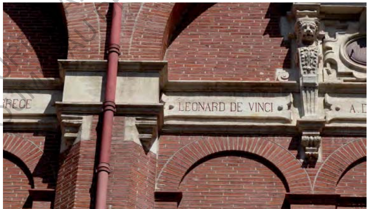
Frise du premier étage de la galerie
