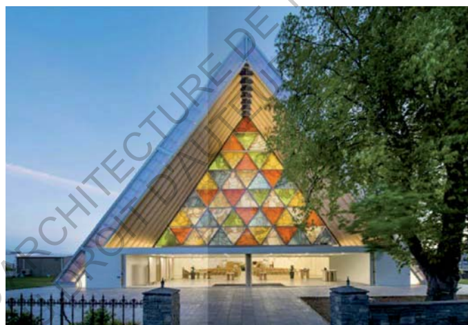
Élevée en un mois, la cathédrale de carton mesure 21 mètres de haut et compte 98 tubes de carton de 60 cm de diamètre.
