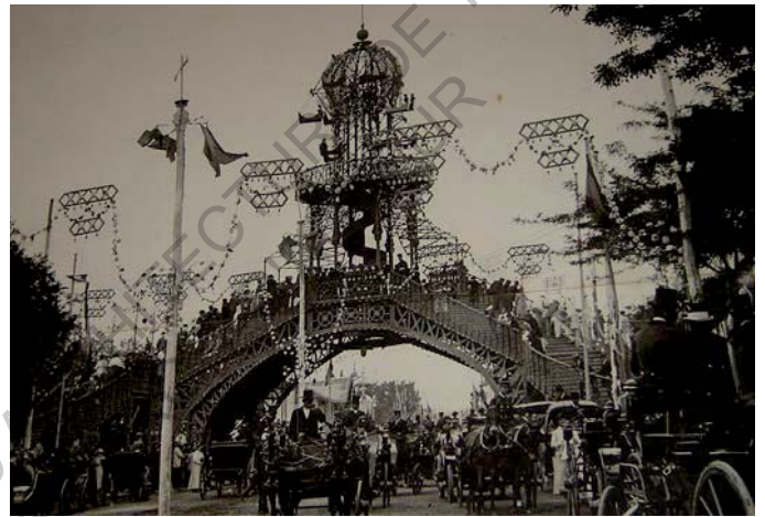
Passerelle en fer, inaugurée en 1896 et démolie en 1920.
