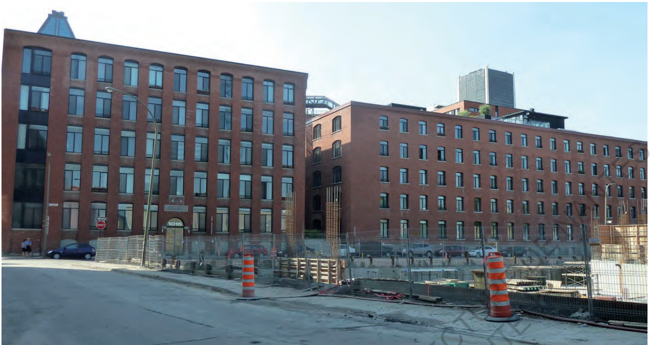
Figure 17 : Ancienne usine réhabilitée, phase 1 et 2 du projet Lowney
