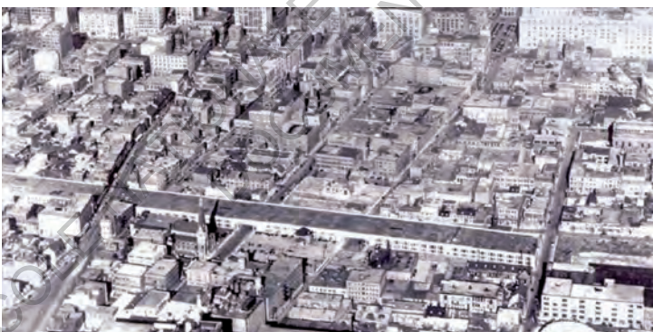
Figure 7 : Viaduc du Canadien National vers 1933
