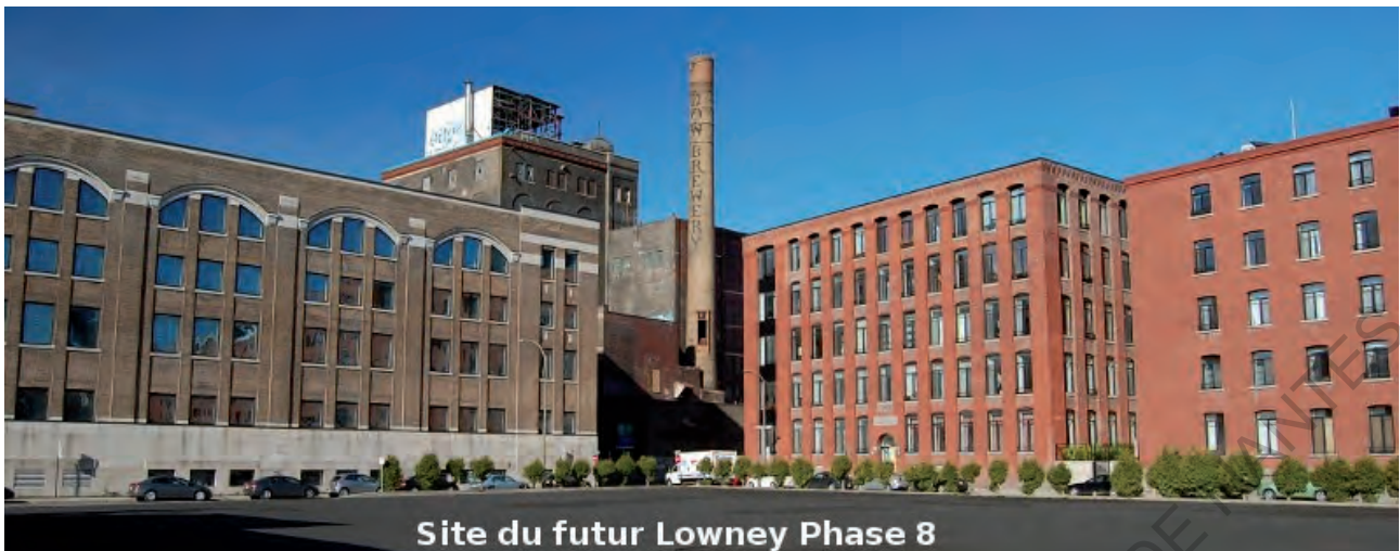
Figure 18 : Site de la phase 8
