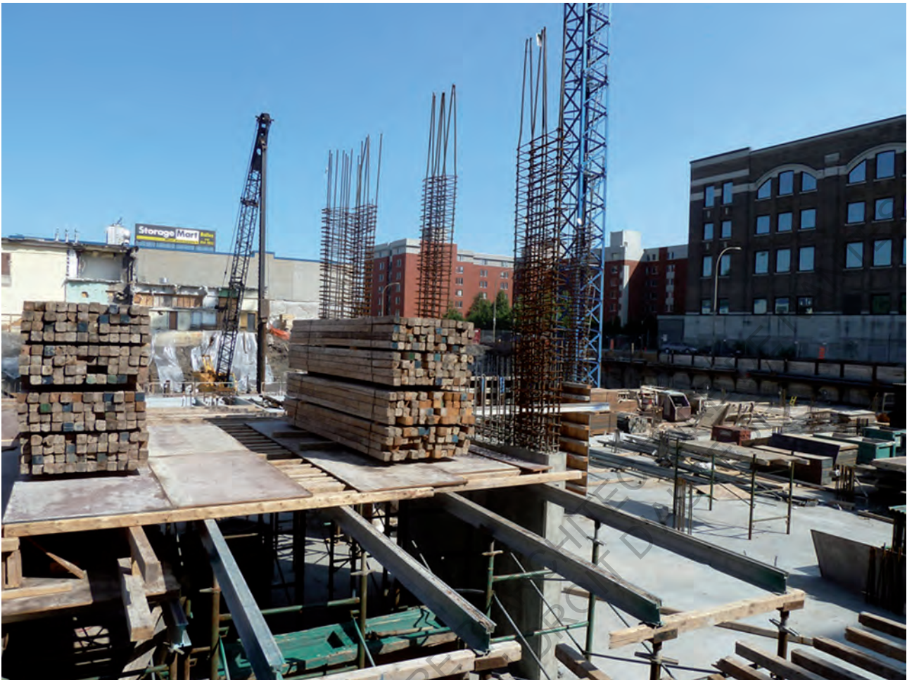
Figure 5 : Construction phase 8 du projet Lowney, Juillet 2011
