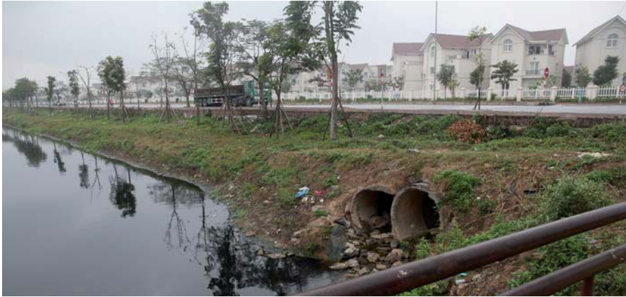
Fig. 40 : Eaux usées de Vinhomes Riverside se jetant dans la rivière Cau Bay. Source : auteur
