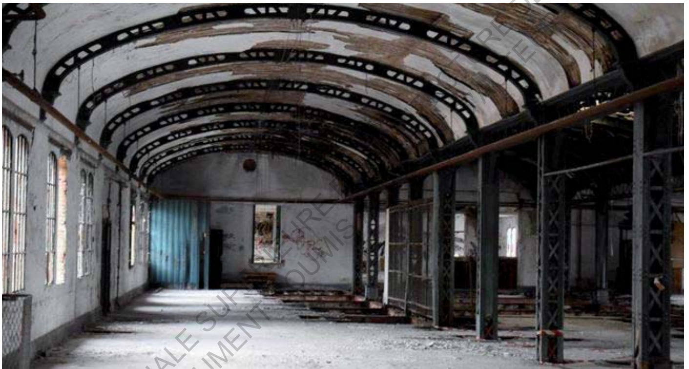
L'étage, Usine Brusson Le lieu vide
