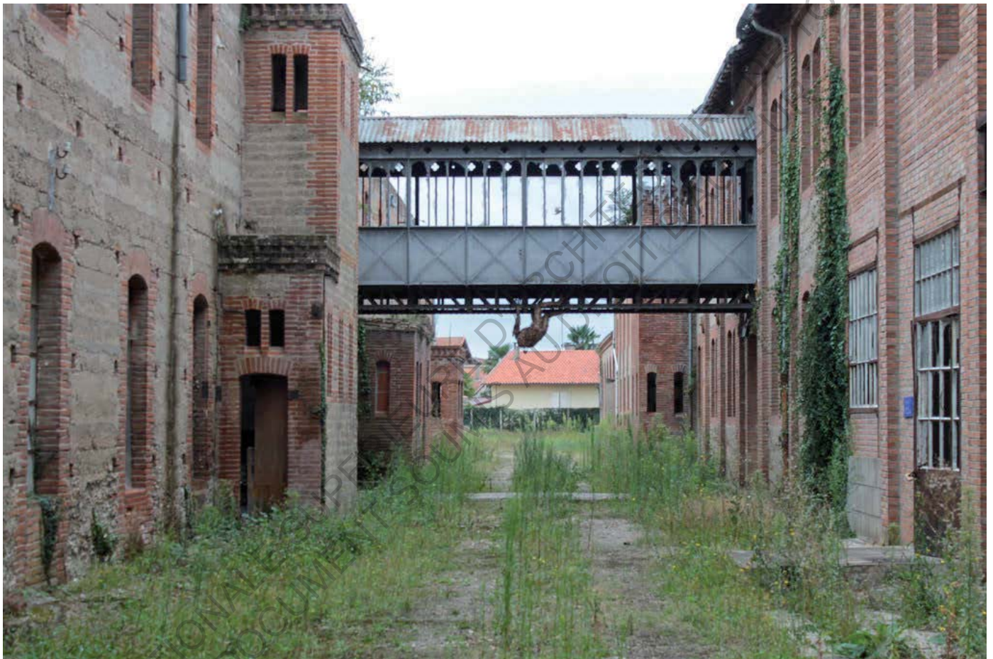
L'entrée et la passerelle, Usine Brusson Le lieu vide
