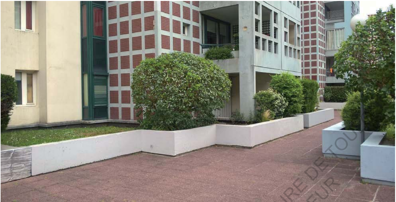
Illustration. 37 Photo de loggia en RDC
