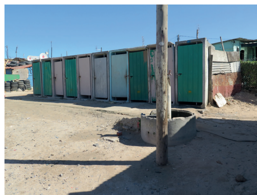
Fig.19. Exemple de toilettes (près d'un point d'eau au premier plan) installées par la municipalité de Cape Town à Monwabisi Park.
