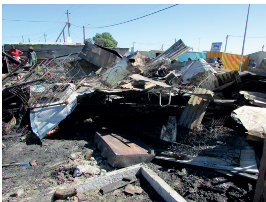
Fig.15. Cet ensemble d'habitations a été détruit par un incendie déclenché par accident par une échoppe de restauration rapide.
