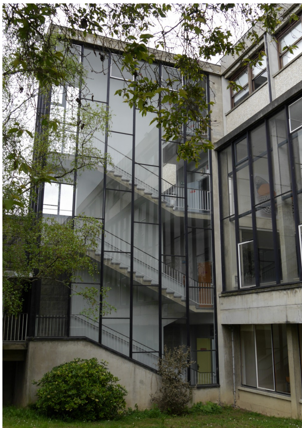
Fig. 57: Photographie des cages d'escaliers du bâtiment central.
