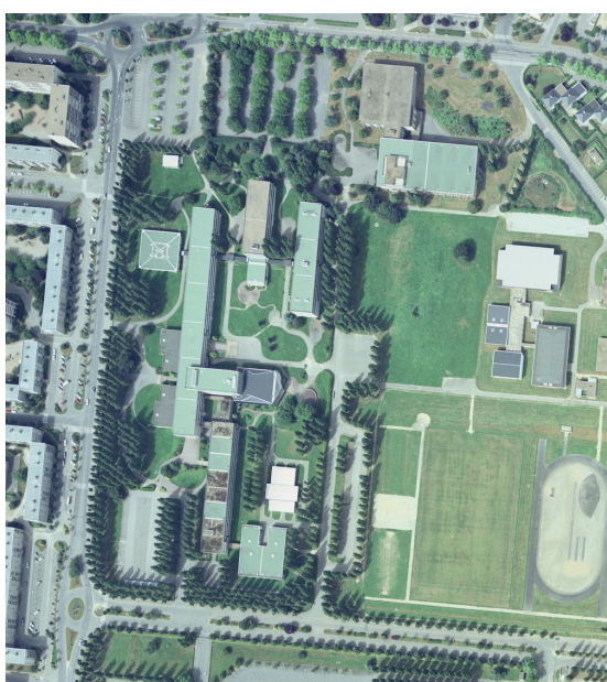
Fig. 41: Photographie aérienne de la faculté des lettres de Rennes. Institut Géographique National. 1987
