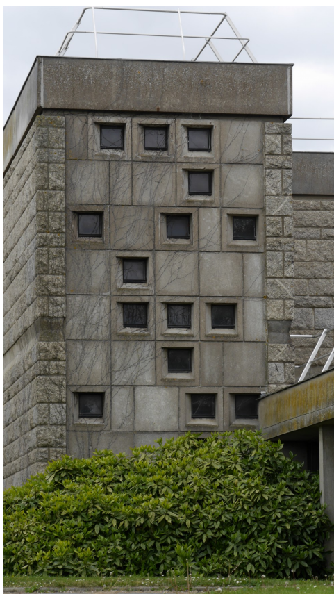
Fig. 61: Photographie du mur pignon.
