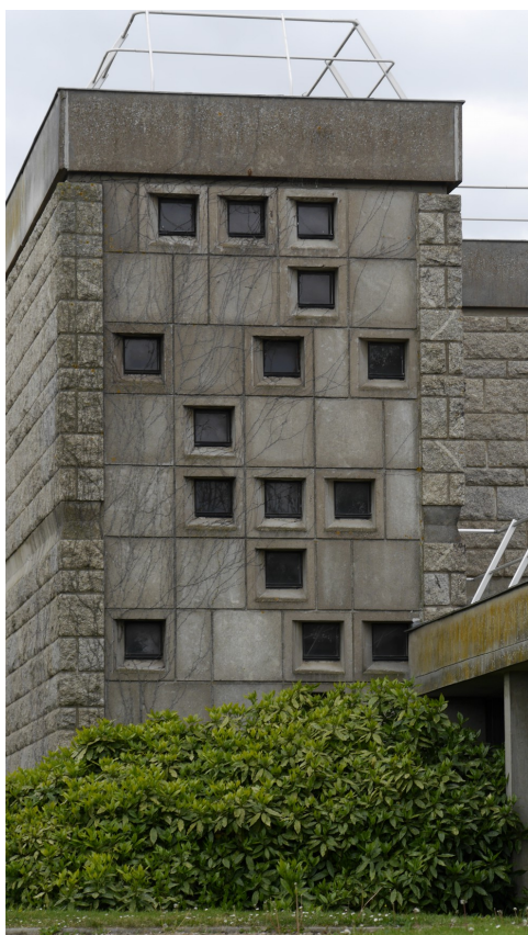
Fig. 61: Photographie du mur pignon.
