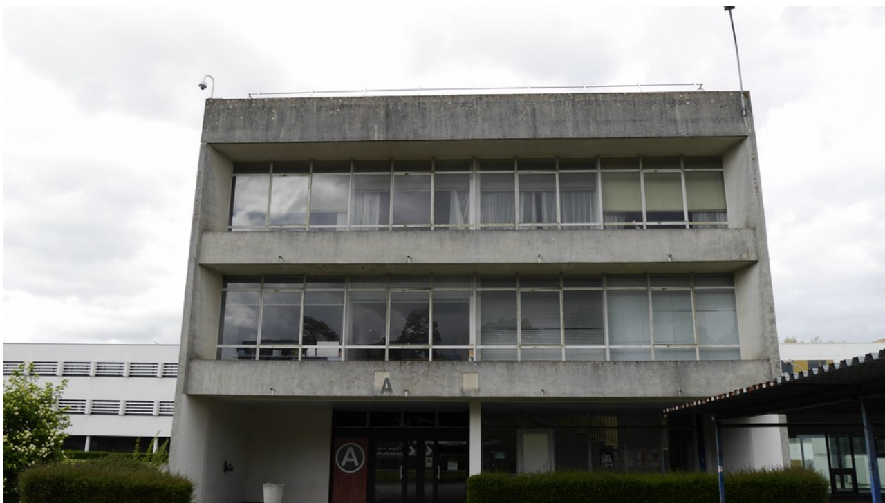
Fig. 54: Portique sud du bâtiment ouest.
