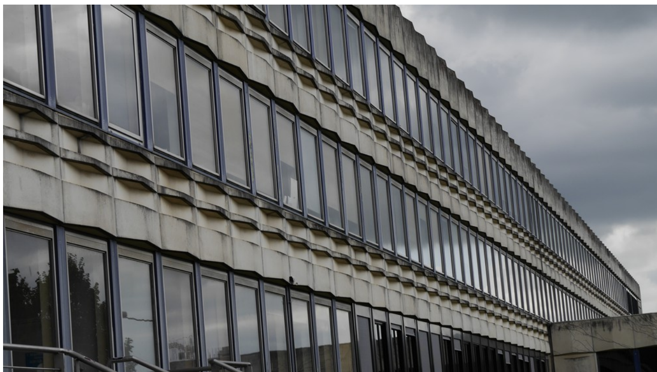
Fig. 39: Photographie du bâtiment ouest depuis le nord. Actuel bâtiment B.
