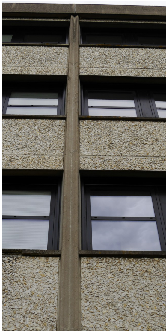
Fig. 59: Photographie de la poutre séparant deux travées sur les corps de bâtiment d'enseignement et vue des modules en pierres lavées ainsi que des menuiseries.
