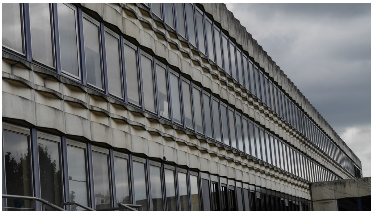
Fig. 55: Photographie de la façade montrant l'alternance des modules bétons et fenêtres
