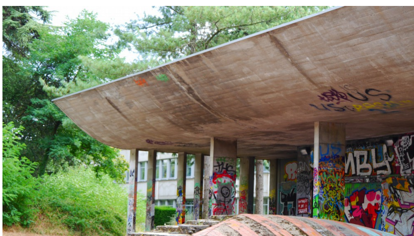
Fig. 64: Photographie du portique ouest de la faculté de droit de Nantes.
