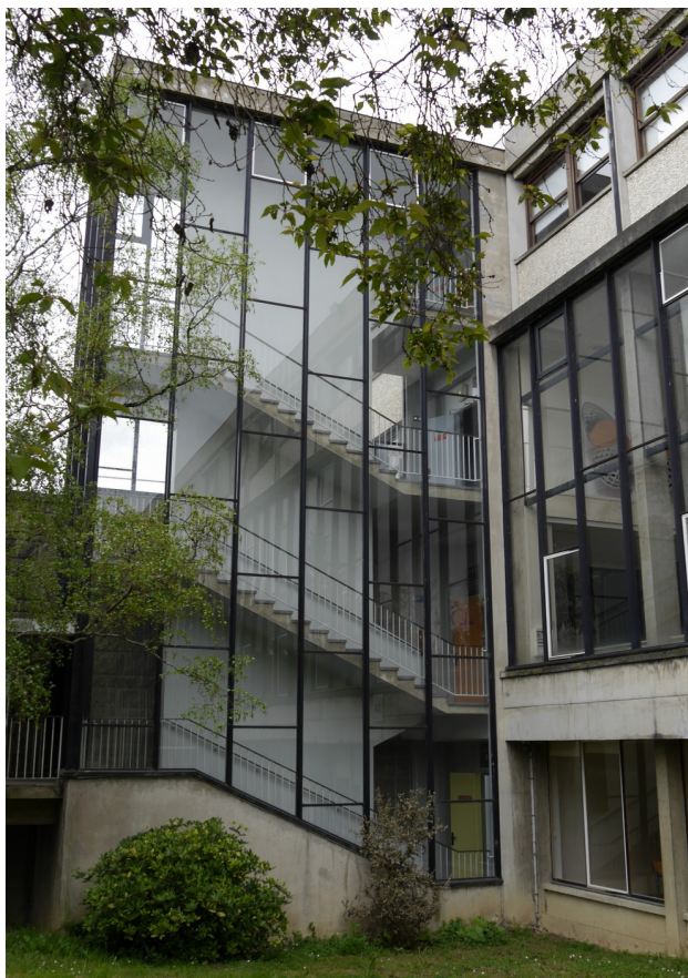
Fig. 57: Photographie des cages d'escaliers du bâtiment central.
