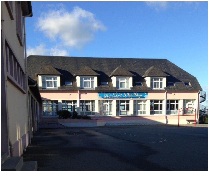
Figure 12 : Groupe scolaire « Le Petit Prince », à Saint-Martin-des-Besaces (le 18/02/2016)
