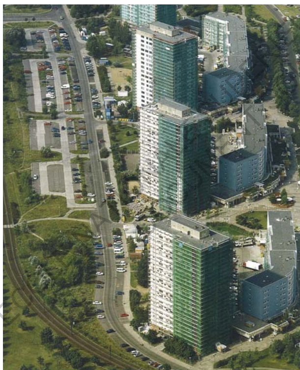
La rénovation des Grands Ensembles par S.T.E.R.N Source : Scan brochure de présentation S.T.E.R.N
