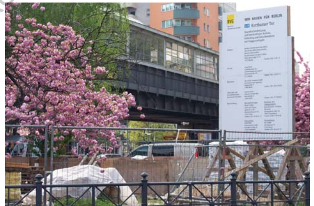
Le coeur de Kottbusser Tor en perpétuel travaux, source personnelle mai 2011
