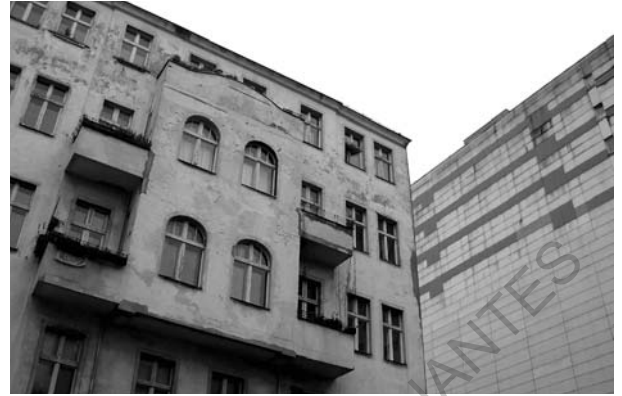
Dresdener Strasse et Kottbusser Tor se confrontent. Source personnelle novembre 2010
