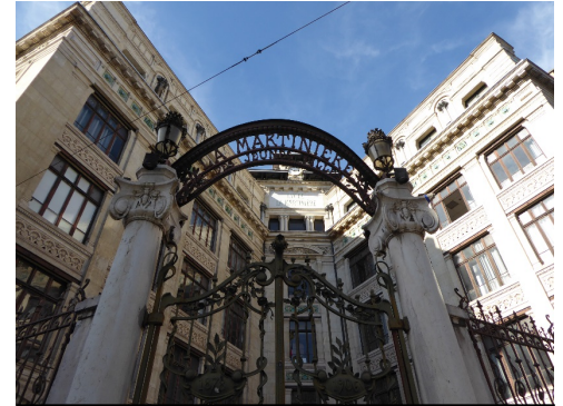
Vue sur le lycée de la Martinière, en bas des pentes de la Croix-Rousse. Photographie personnelle
