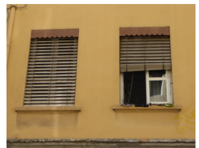
Détail de jalousies sur un immeuble canut. Photographie personnelle
