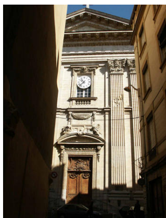
Vue sur l'Eglise Saint Polycarpe. Source : base Osiris
