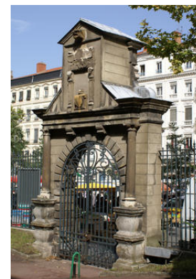
Portail du château de la Tourette. Source : Osiris
