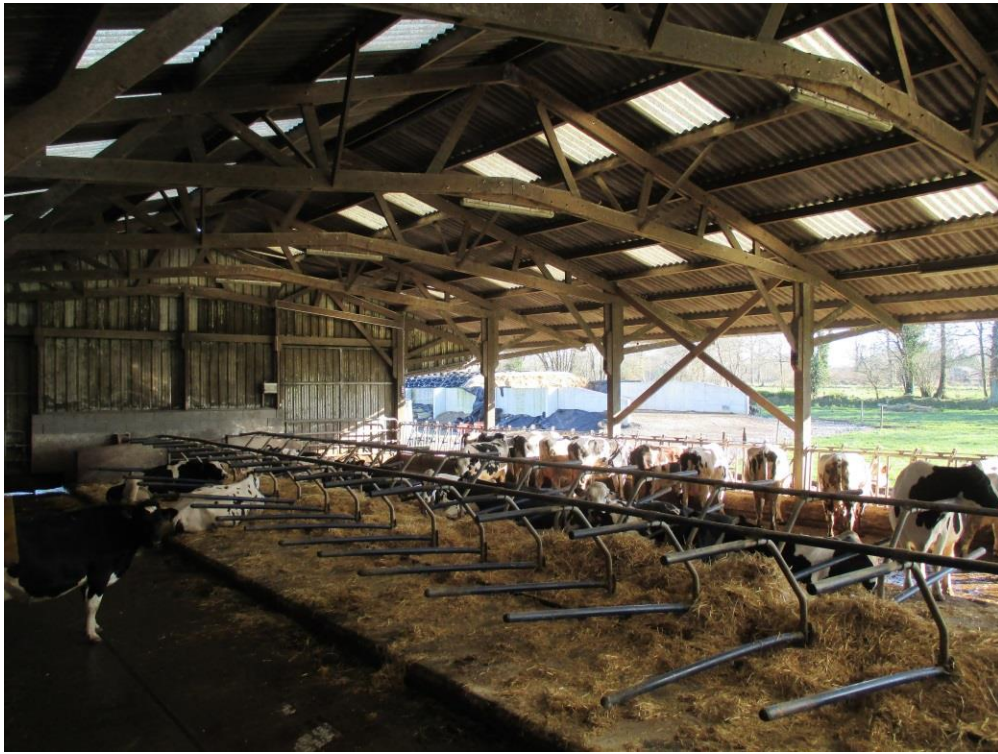
Photo 3 – Les bâtiments sont réaménagés au service de la traite robotisée. L'abandon de l'aire-paillée au profit du couchage en logette devient primordial. L'emplacement du RDT et des bâtiments nécessite un parcellaire groupé pour permettre le pâturage. Dans la majeure partie des cas, l'abandon progressif du pâturage est la suite logique de l'adoption du robot [U.L., 02/16].
