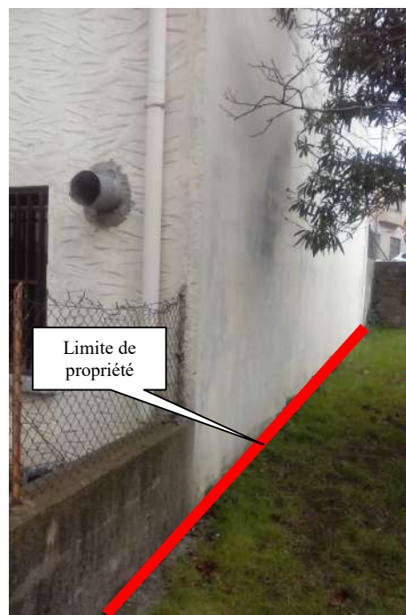
Figure 5 – Exemple de mur matérialisant une limite de propriété (photographie personnelle)
