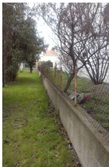
Figure 14 – Photographie d'une parcelle encerclée par une clôture et faisant l'objet d'un bornage
