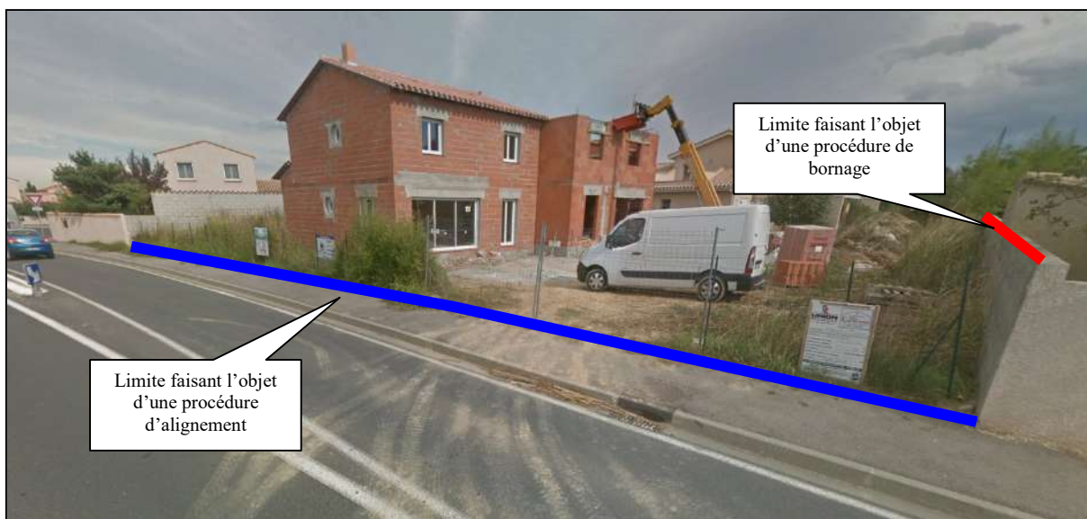
Figure 16 – Photographie commentée illustrant le champ d'application de la procédure d'alignement – Crédit photographique : Google Street-View [GOOGLEMAPS2017]
