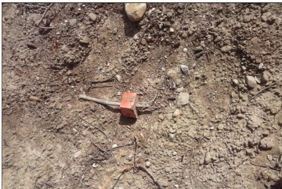
Figure 12 – Borne OGE dégradée sur un chantier de lotissement sur la commune de Clairac
