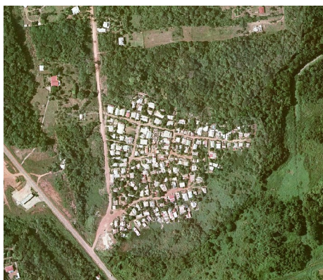
Figure 10 : Avant les opérations de RHI : quartier « BP 134 » en 2001 (BD ORTHO® 2001)
