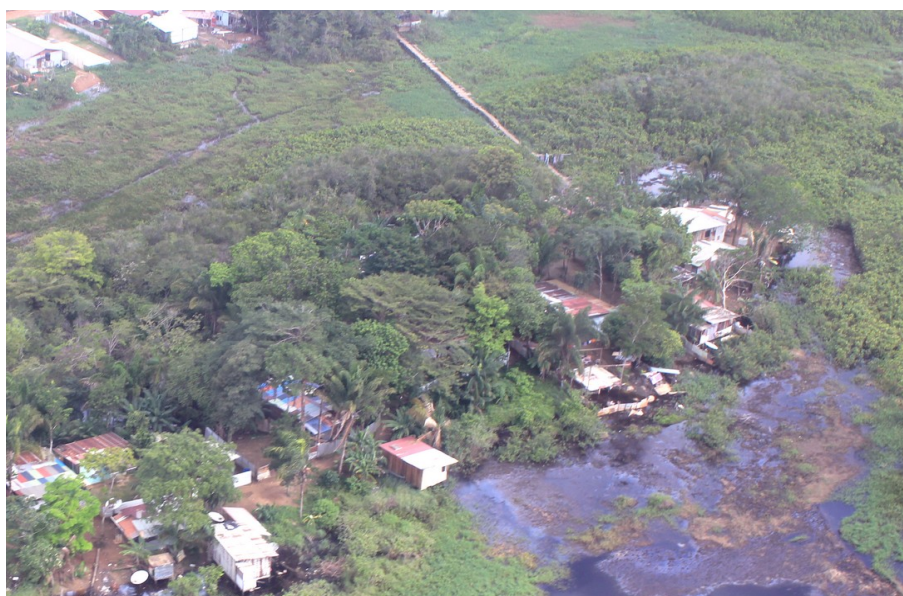
Figure 33 : Des constructions sous les arbres (photo S. LINARES, janvier 2017)
