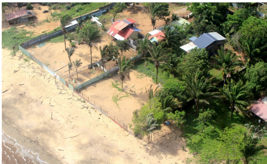
Figure 7 : Construction illicite, sur la plage (photo S. LINARÈS, janvier 2017)
