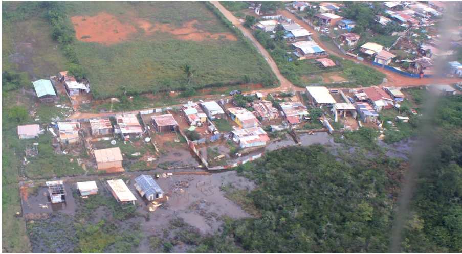
Figure 8 : Habitat indigne et informel, secteur de Collery Ouest (photo S. LINARES, janvier 2017)
