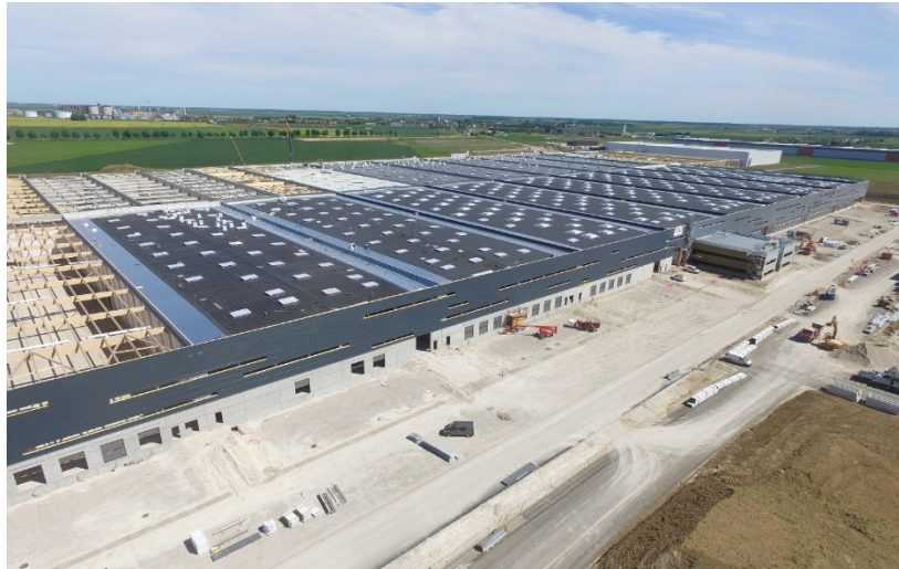
Figure 26 - Photo drone du chantier Carrefour Poupry
