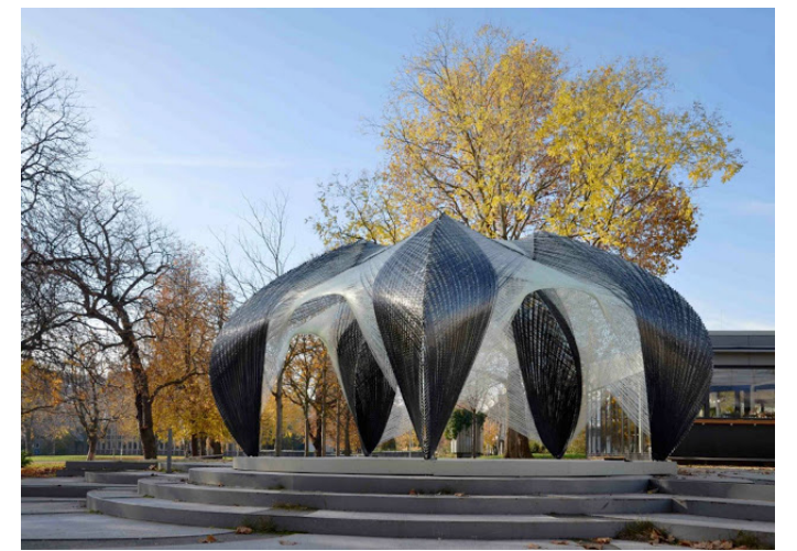
Research Pavillon : Achim Menges. Travail sur une structure en fibre de verre et de carbone.
