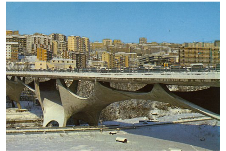
Il ponte Sul Basento di Musmeci, 1976 (Italie).
