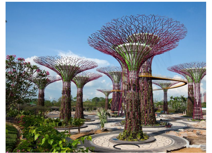
Supertrees : Garden by the bay Singapour. Grant Associates et Atelier 10 en tant qu'ingénieur structure.
