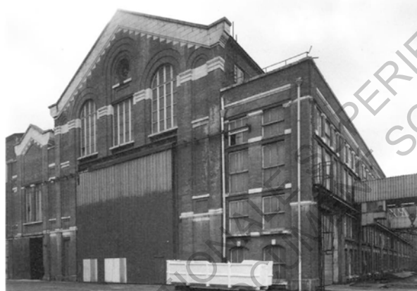
Fig 21 - Usine électrique de Chantenay (1913)
