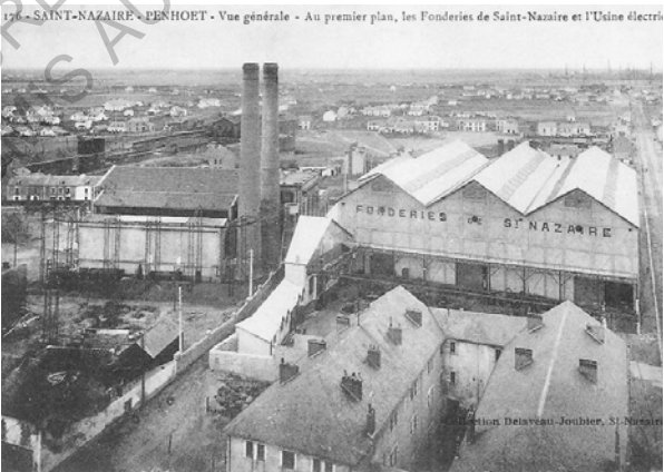
Fig 22 - Usine électrique de Penhoët en 1918
