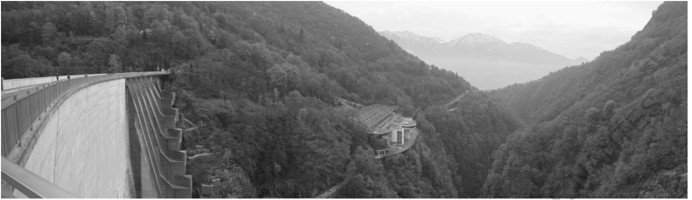
Fig 59 - Barrage hydraulique de Contra, Val Verzasca, Suisse.
