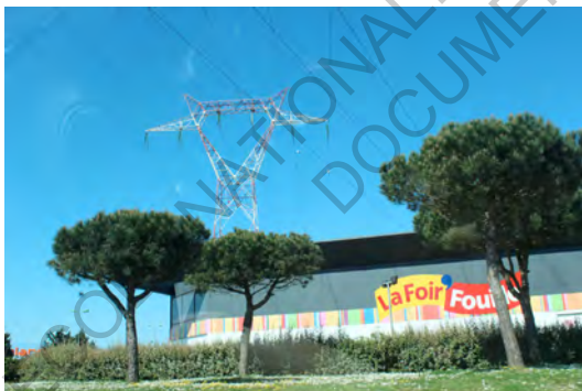
d - Environs de Montoir, transformateur électrique e - Ligne HT et zone commerciale, entrée de St Nazaire
