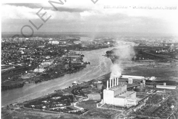
Fig 23 - Centrale de Chevéré en 1962
