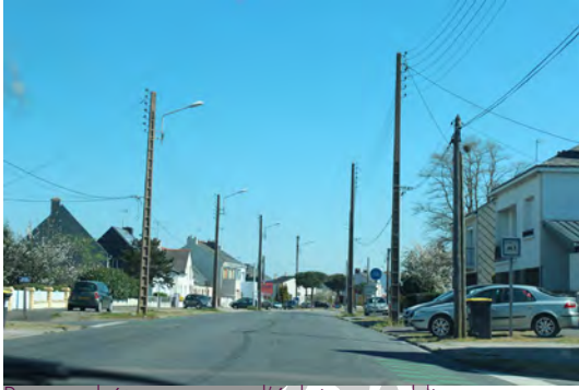
Poteaux béton support d'éclairage public St Nazaire, bd de la Liberté
