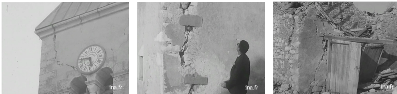
Figure 13 : Dégâts dus au séisme de Corrençon en 1962. Source : ina.fr
