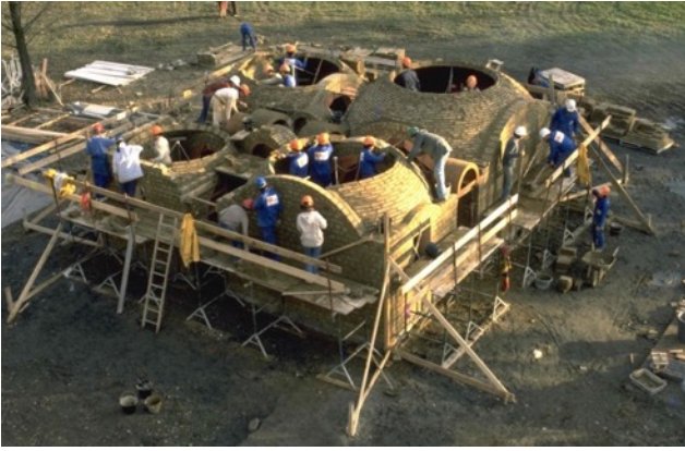
Figure 3 : Construction des coupoles du toit de la maison Source : Patrice DOAT
