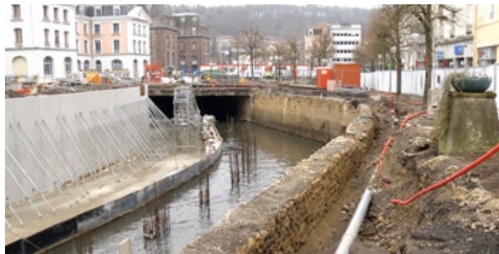
Travaux de découverte de la Chiers, source: mirabelle tv
