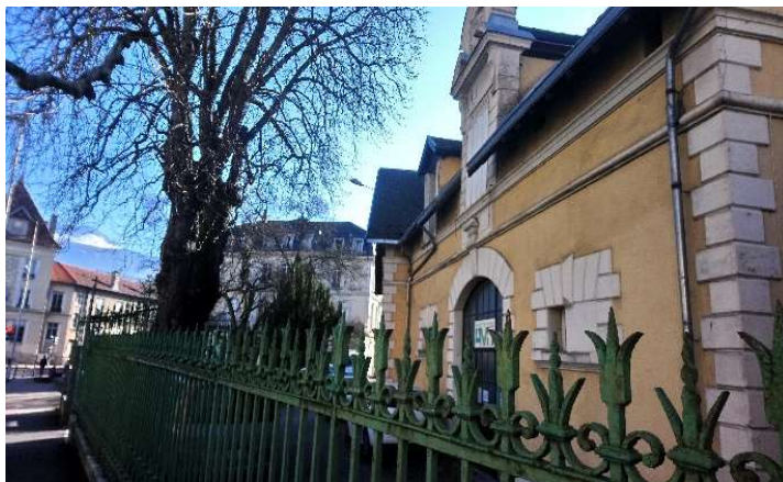
Voiron, Annexes Mille-Pas, dans les abords d'un monument historique, Photo de l'auteur
