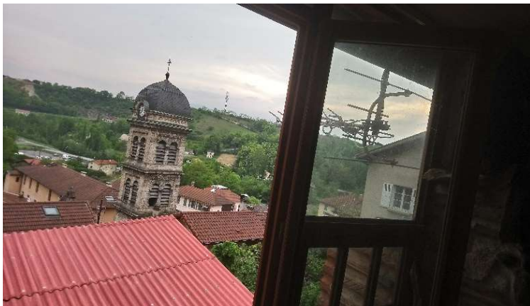
La cohabitation d'une antenne râteau avec le clocher aurait-elle été possible si cette zone du quartier médiéval avait fait l'objet d'une inscription ? ; photo de l'auteur
