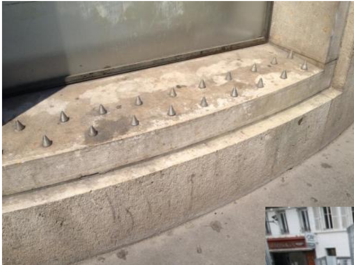
Figure 27 et 28 : Aménagements défensifs. Sur les grands boulevards à Paris (à gauche). Et à Angoulême (ci-dessous).
