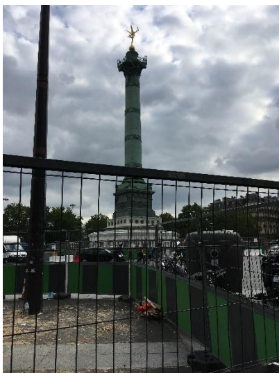
Figure 20 : Photo du chantier actuel
