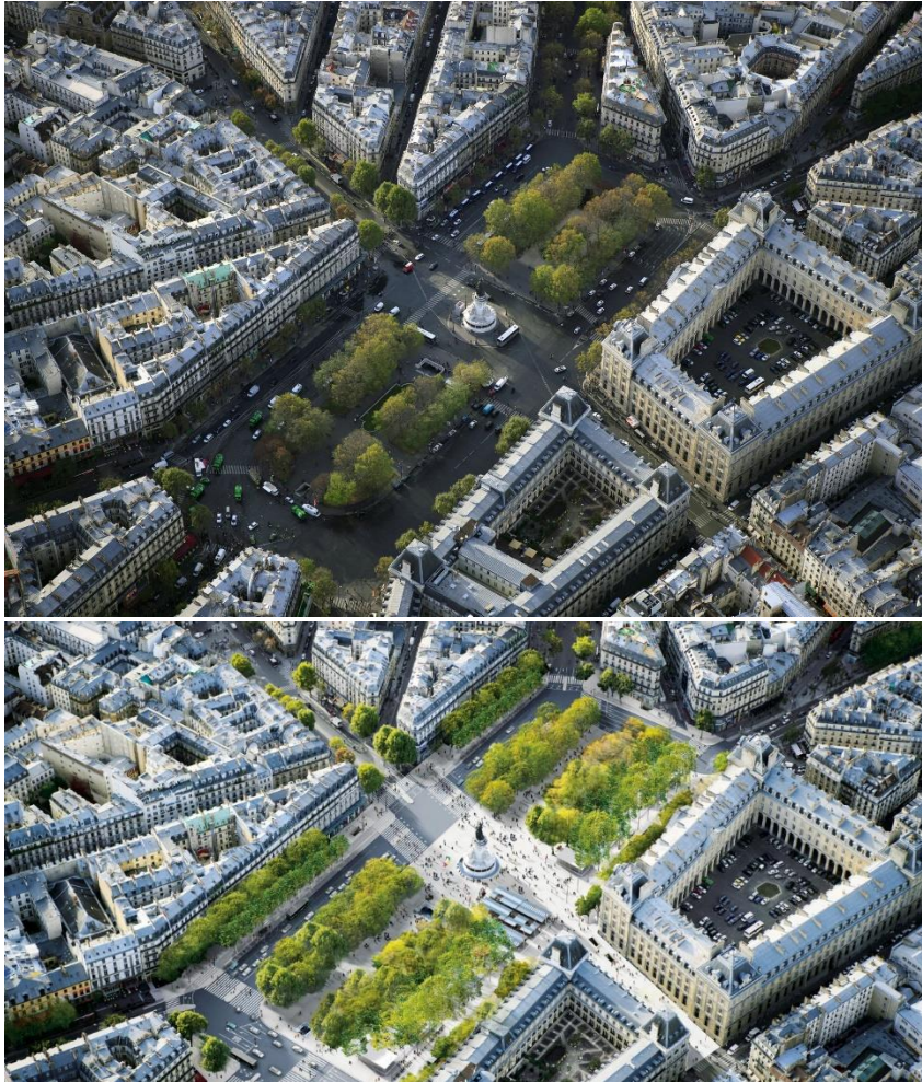
Figure 23 : Comparaison avant et après le réaménagement de la place de la République. (Source :TVK)
