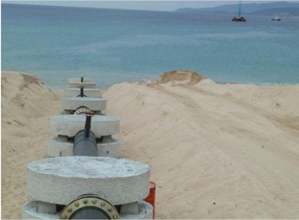
Figure 75 : Lests d'un émissaire d'une station d'épuration à Cap d'Agde (Source : Cahiers Techniques du Bâtiment)
