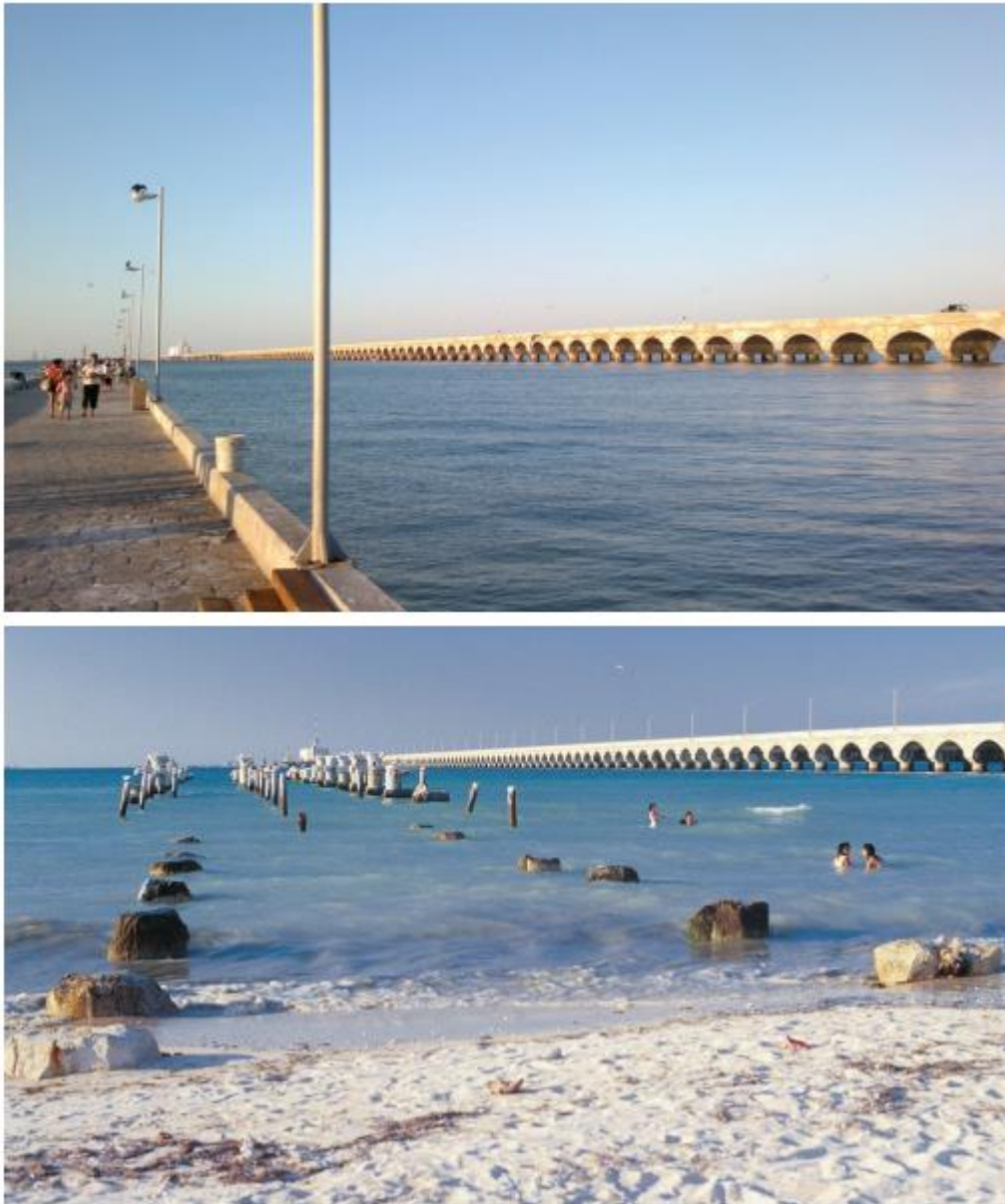
Figure 68 : Chronologie du vieillissement des 2 estacades de Progresso (Source : Nickelinstitute)
