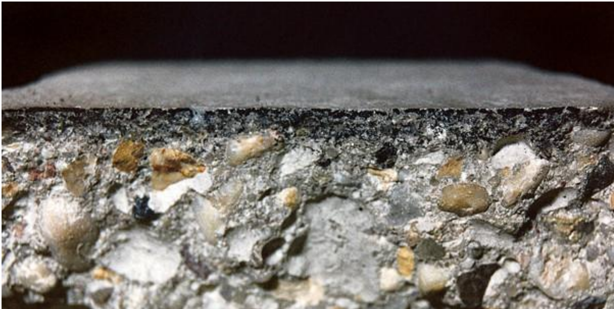
Figure 44 : Photo d'un béton coffré avec un textile drainant (Source : EGCO)
