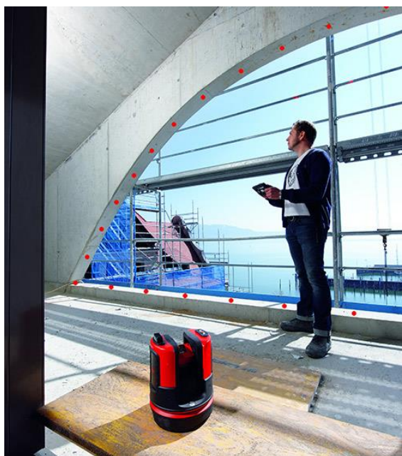
Figure 31 - Relevé de bâtiments par lasermetre Disto 3D ( www.viz-all.fr – juin 2016)
