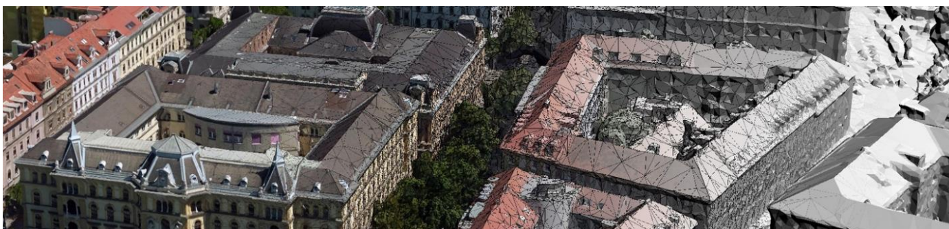
Figure 32 - Relevé de bâtiment par la technologie ContextCapture de Bentley ( www.bentley.com )
