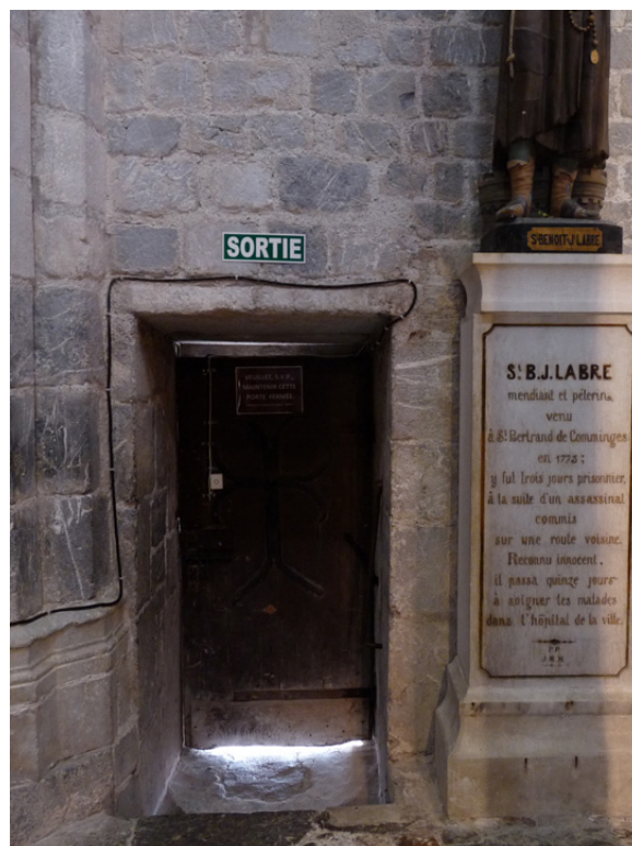
Figure 75 : 3ème travée, mur gouttereau nord : porte moderne.
