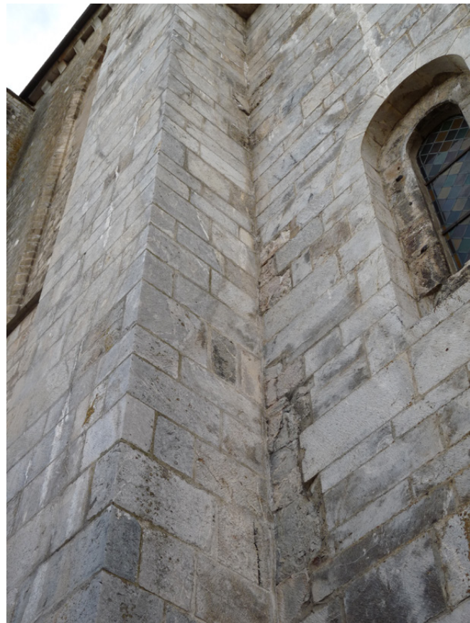
Figure 45 : Façade nord, 1ère travée : chaînage avec le contrefort est.
