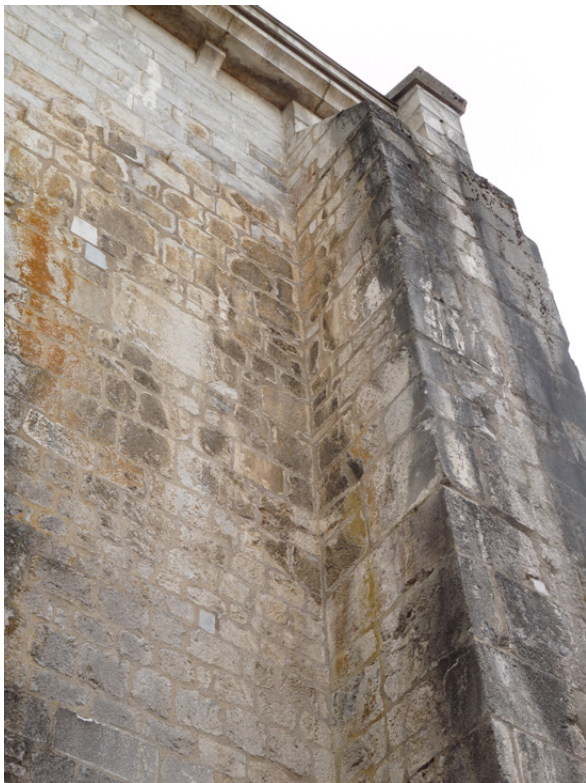
Figure 44 : Façade nord, 1ère travée : chaînage avec le contrefort ouest.
