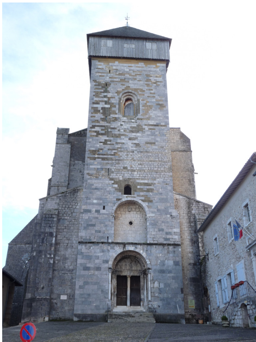
Figure 17 : Façade ouest depuis le bas de la place.
