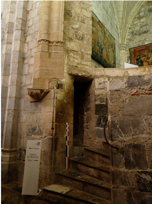
Figure 78 : 4ème travée, côté sud : porte de l'escalier d'accès aux terrasses dans la courbure de l'escalier de la chapelle de Cosnac.
