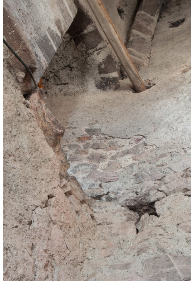
Figure 101 : Salle haute, mur sud, ébrasement de l'archère sud du mur est : parement rejointoyé avec mortier à petits cailloux.
