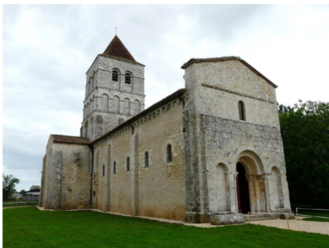
Figure 144 : Église Saint-Michel-de-Rouviac de Nant (Aveyron) : vue général sud. (crédit : John Naylor)
