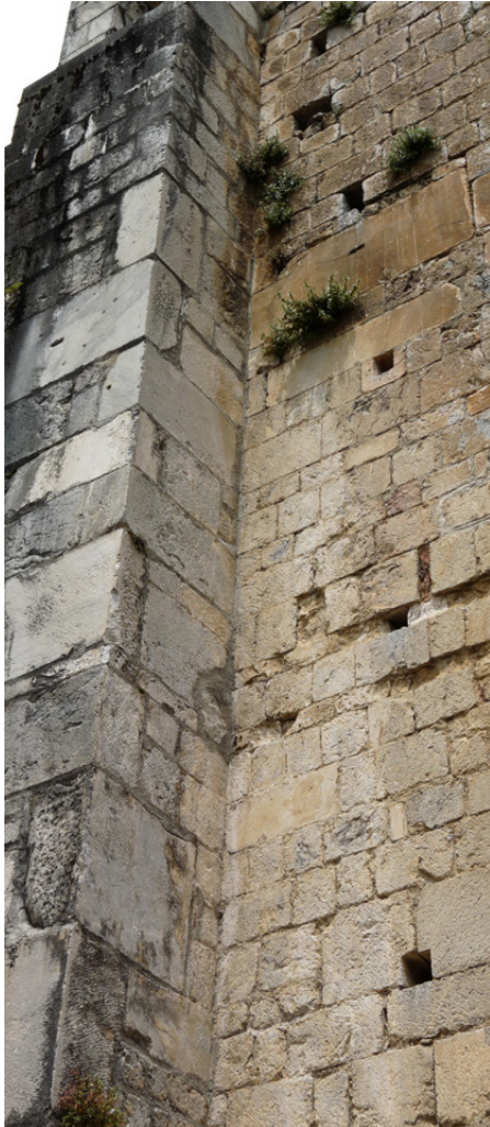
Figure 53 : Façade sud, 1ère travée : chaînage avec le contrefort ouest.
