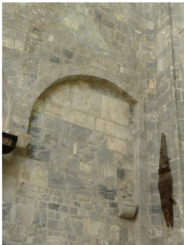
Figure 70 : 2ème travée, mur gouttereau sud : ressaut occidental de l'arcature.
