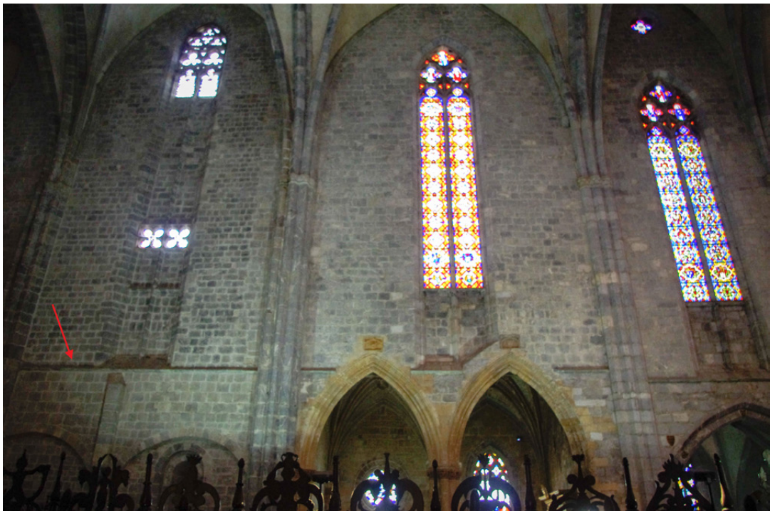
Figure 20 : Moulure de séparation entre les murs romans et la reconstruction gothique, mur nord des 3ème et 4ème travées de la nef.
