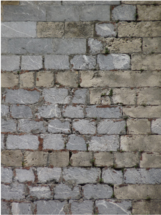
Figure 26 : Trou de boulin bouché de la façade ouest du clocher.
