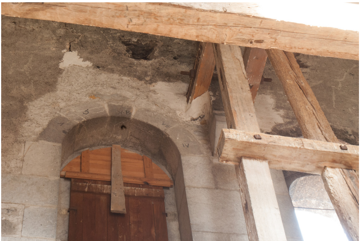
Figure 99 : Salle haute, mur nord : arc de la baie jumelée ouest.
