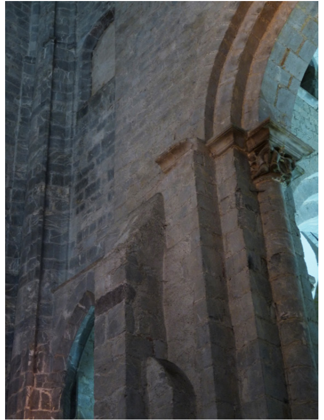
Figure 83 : Pilier à ressauts sud : ressauts coupés à l'est.
