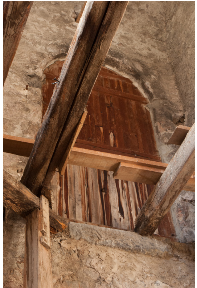
Figure 104 : Salle haute, mur ouest : baie en plein cintre et bandeau d'appui.
