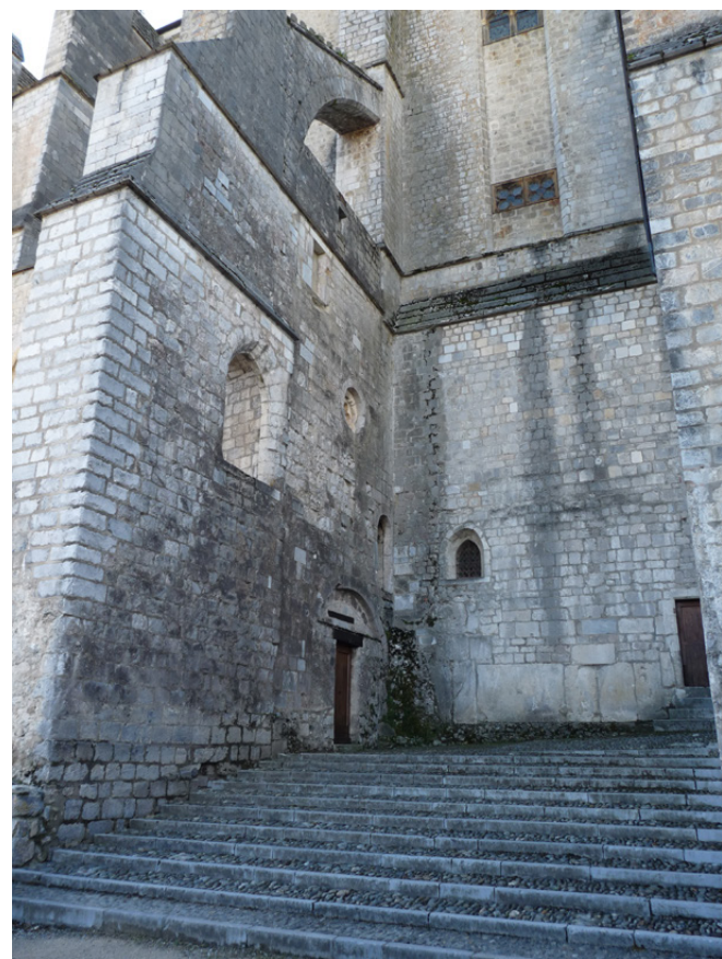
Figure 47 : Façade nord : mur ouest de la chapelle de Castillon et mur de la 3ème travée.
