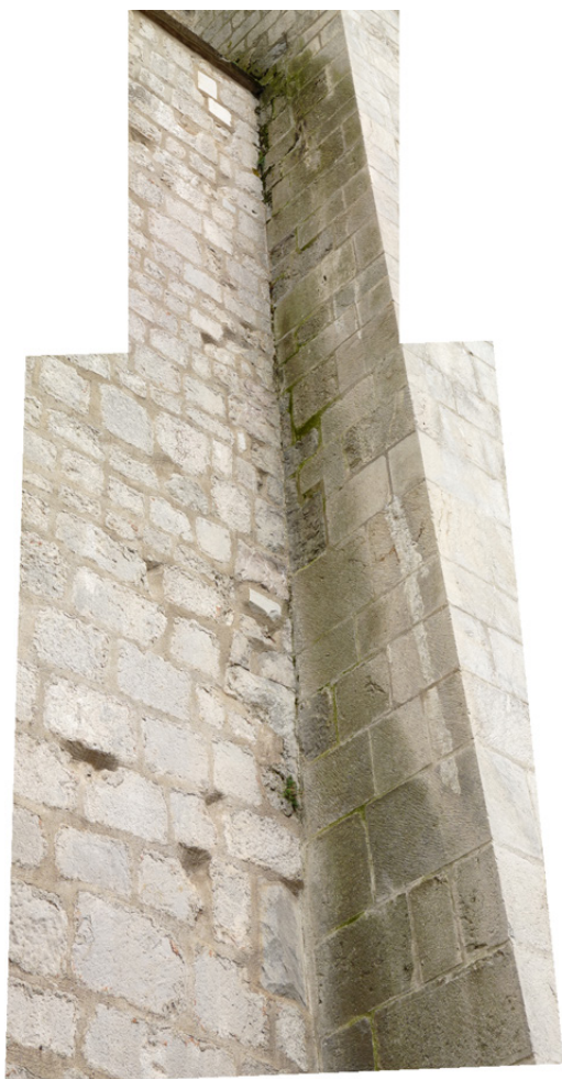
Figure 46 : Façade nord, 2ème travée : chaînage avec le contrefort ouest. Photomontage.
