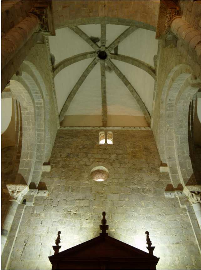
Figure 18 : Voûte en arc-de-cloître de la première travée.
