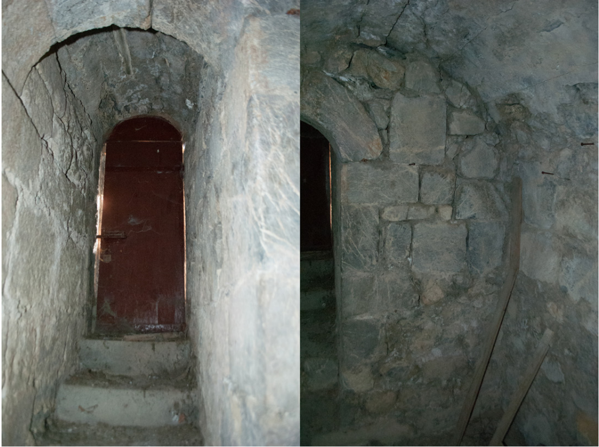
Figure 91 : Salle sud du passage : porte ouverte dans la face sud du clocher.
