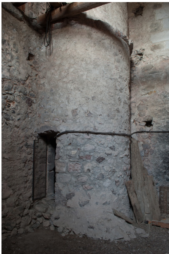
Figure 93 : Cage d'escalier dans la salle haute.
