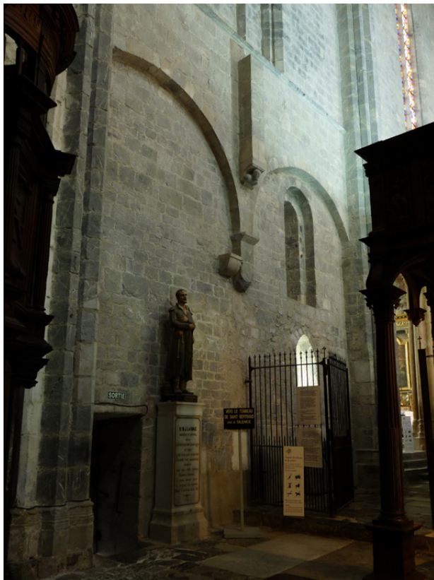
Figure 65 : 3ème travée, mur gouttereau nord.
