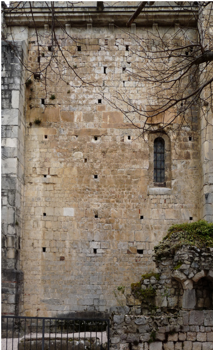
Figure 52 : Façade sud, 1ère travée. Photo-montage.
