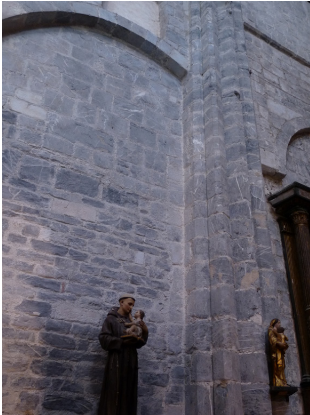
Figure 73 : 3ème travée, mur gouttereau sud : arc occidental.
