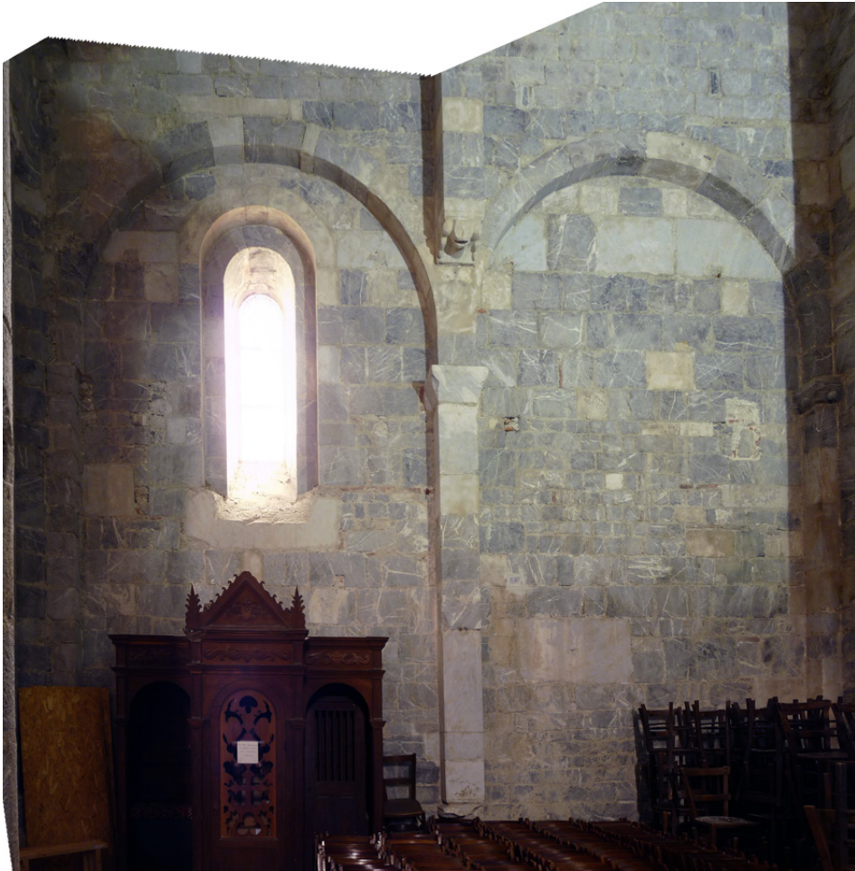
Figure 62 : 1ère travée, mur gouttereau sud. Photomontage.
