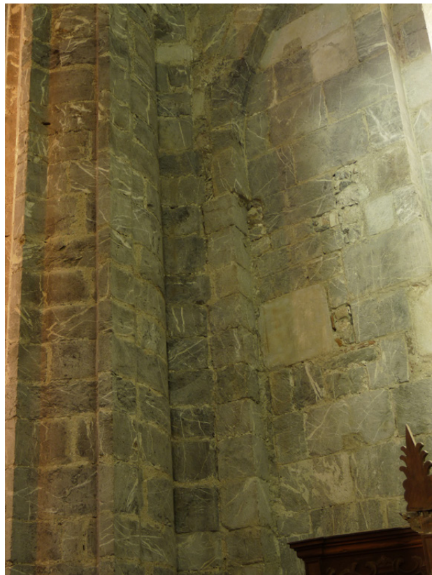
Figure 68 : 1ère travée, mur gouttereau sud : ressaut oriental de l'arcature.
