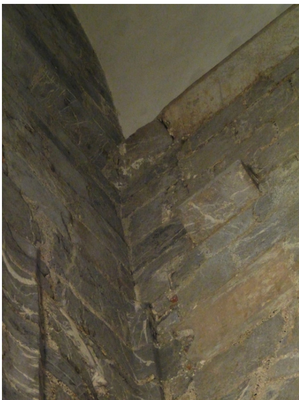
Figure 69 : 1ère travée, mur gouttereau sud : vestige d'imposte au-dessus de l'arcature.
