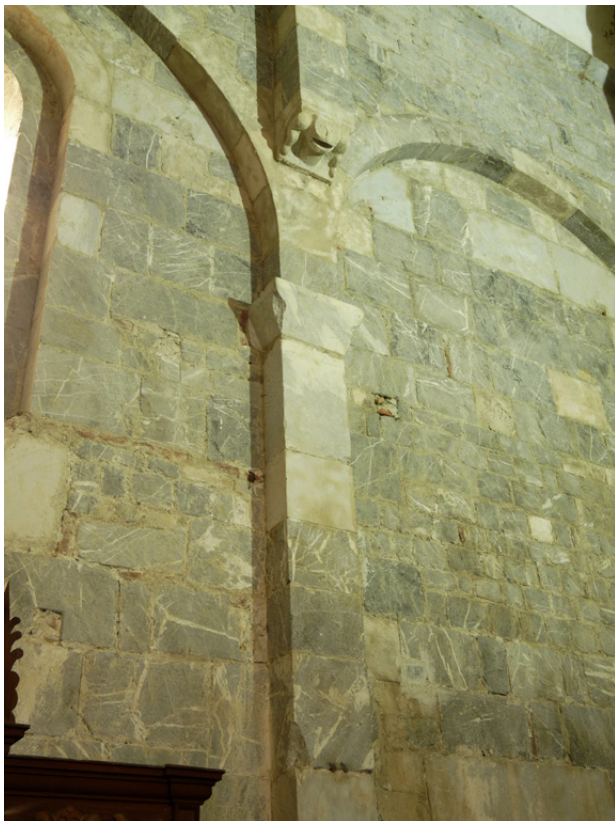
Figure 67 : Détail du pilastre du mur sud de la 1ère travée.
