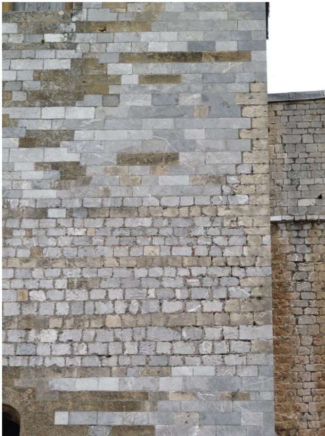
Figure 24 : Façade ouest : Parement d'assises anciennes en bandes bicolore.
