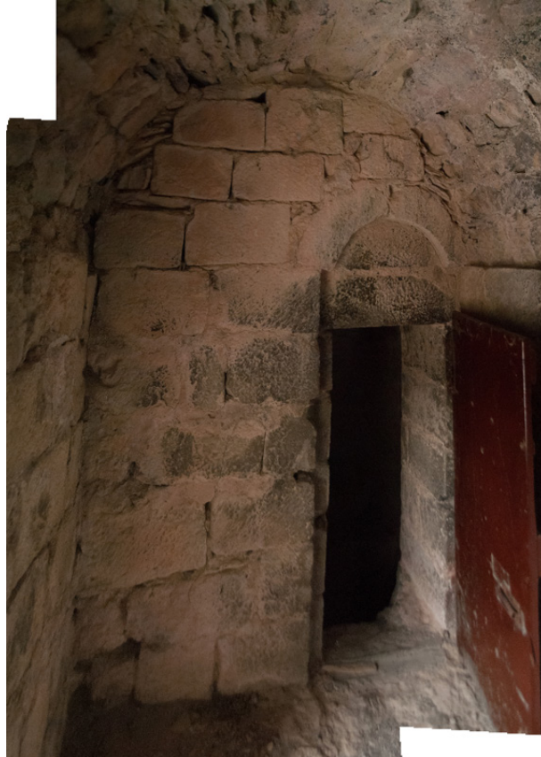
Figure 90 : Mur nord et accès du passage intermédiaire. Photomontage.
