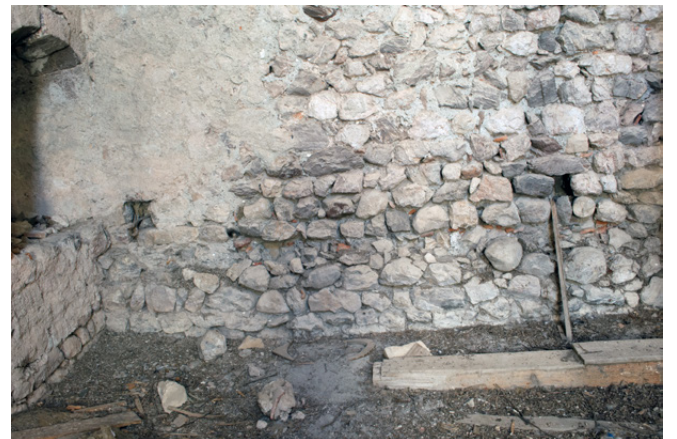
Figure 102 et 102b : Salle haute, mur sud : « banquette » au bas du mur.
