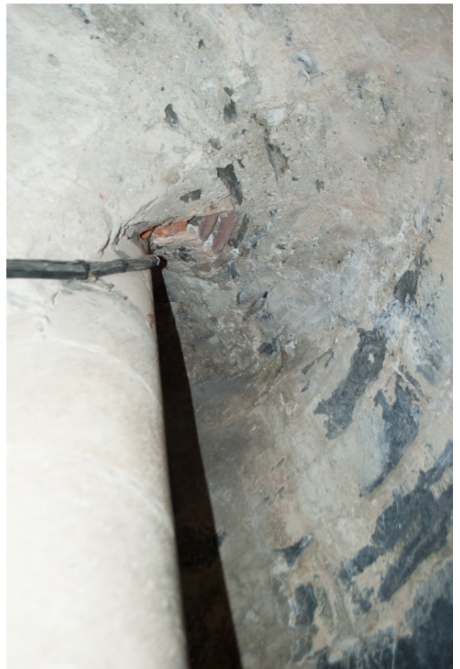
Figure 87 : Escalier du clocher : voûte hélicoïdale portant les marches.
