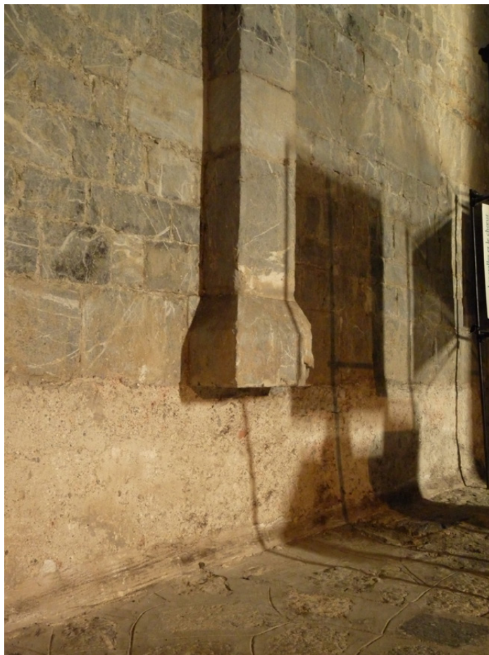
Figure 21 : Mur nord de la 1ère travée : bûchage enduit de la banquette sous le pilastre inférieur.
