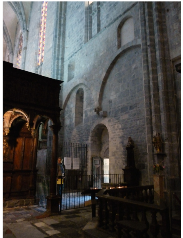
Figure 66 : 3ème travée, mur gouttereau sud.
