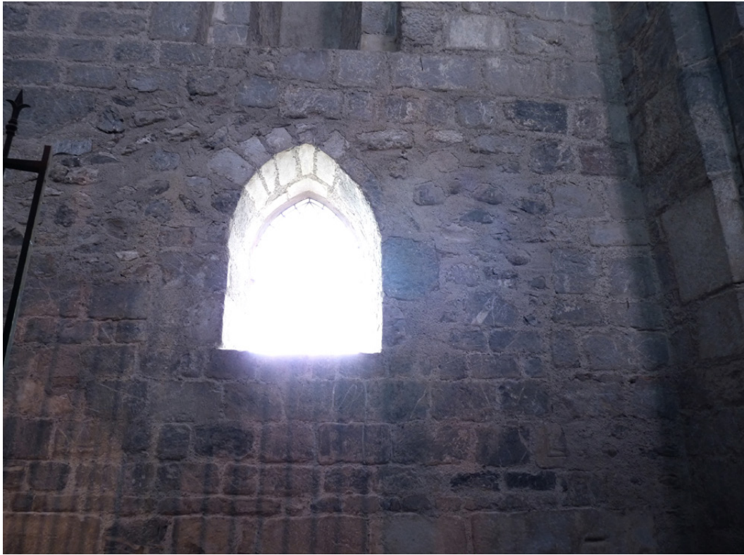
Figure 76 : 3ème travée, mur gouttereau nord : baie gothique ouverte sous l'arc oriental.
