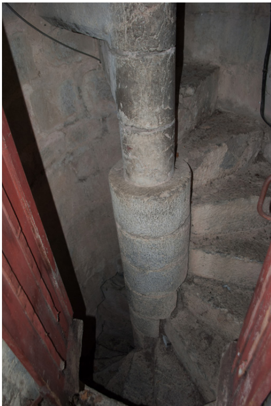
Figure 80 : Escalier en vis des terrasses des chapelles : transition entre le noyau à tambour roman et les marches portant noyau modernes.
