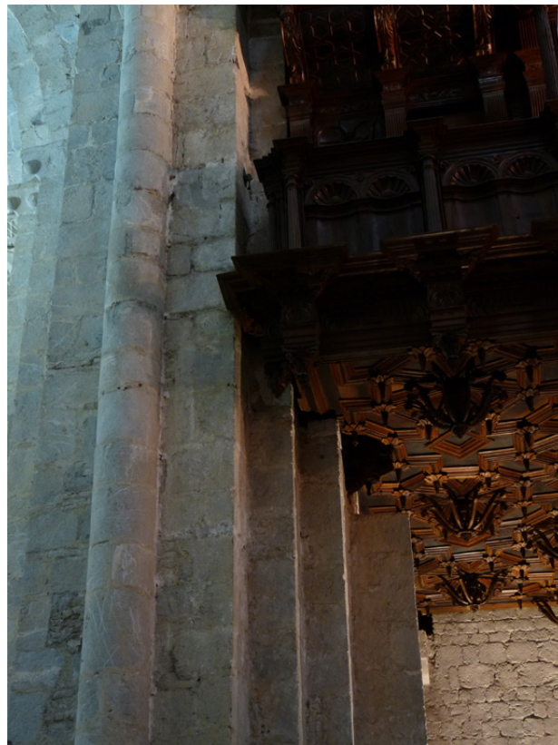
Figure 84 : Pilier à ressauts nord : ressauts coupés à l'est pour former une base pour l'orgue.
