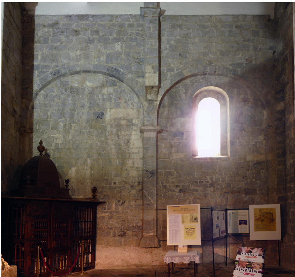
Figure 63 : 1ère travée, mur gouttereau nord. Photomontage.
