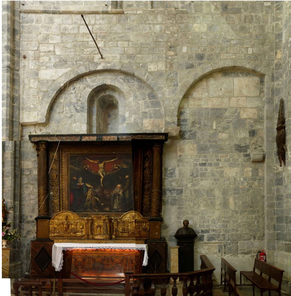
Figure 64 : 2ème travée, mur gouttereau sud. Photomontage.
