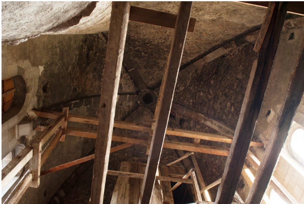
Figure 105 : Salle haute : voûte en arc-de-cloître.
