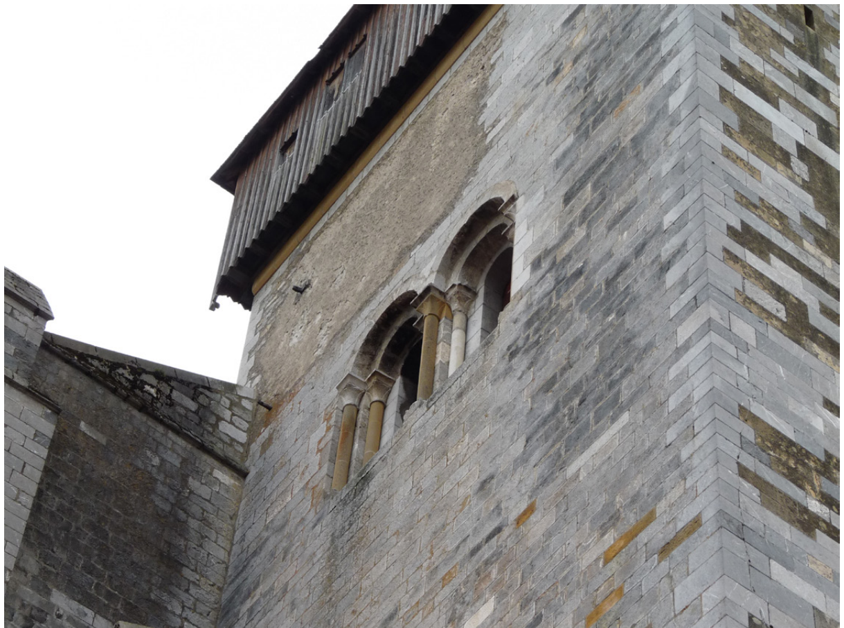
Figure 27 : Face nord du clocher : zone enduite au-dessus des baies géminées restaurées.
