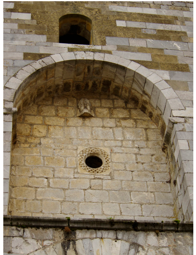
Figure 25 : Intrados de la niche en plein cintre du clocher (crédit : Arzhêliz Diard).
