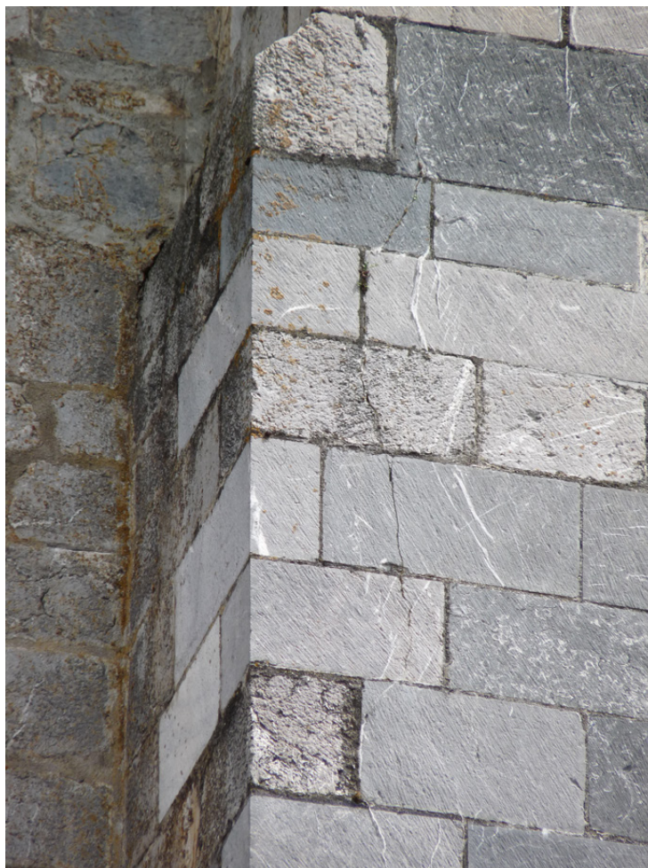
Figure 36 : Détail des assises en carreaux à l'angle nord de la façade du clocher.
