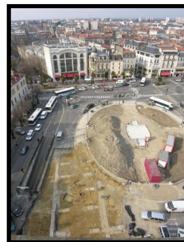
Figure 11 : Aménagement de la Place Clémenceau en 2004 Source : INRAP
