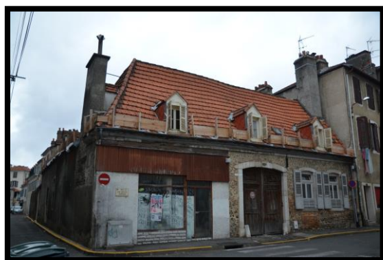
Figure 19 : 20 rue Carreau, avant démolition Source : SIAB
