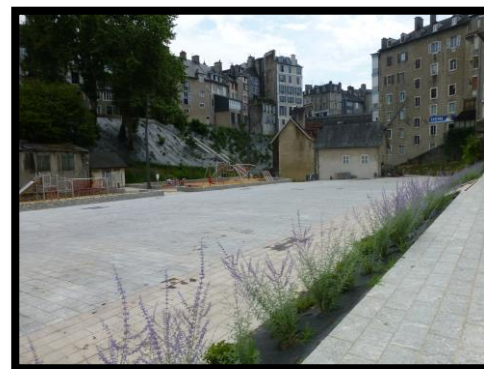
Figure : 22 Hédas après travaux Source : SIAB
