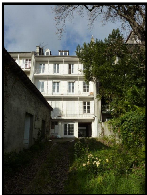
Figure 15 : 49 rue Emile Guichenné avant travaux Source : SIAB
