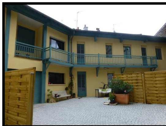
Figure 14 : Rénovation de l'immeuble au 23 rue Lespy Source : SIAB
