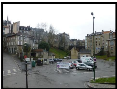
Figure 21 : Hédas avant travaux Source : SIAB
