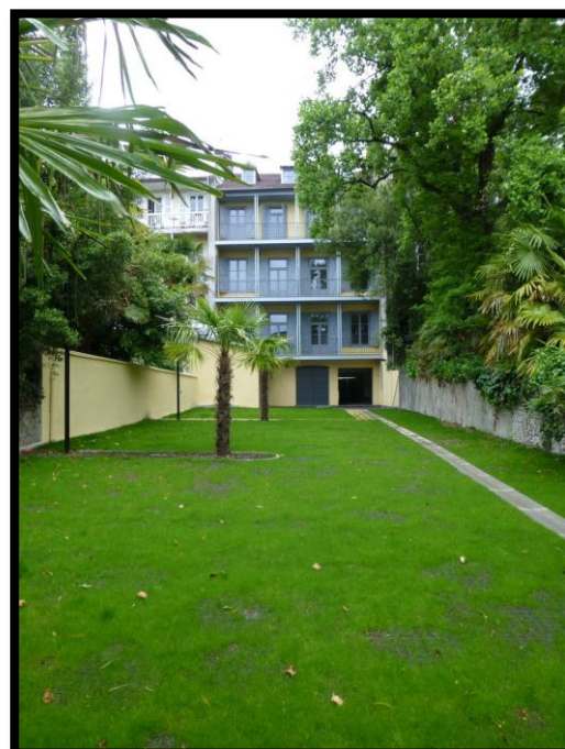
Figure 16 : 49 rue Emile Guichenné après travaux Source : SIAB
