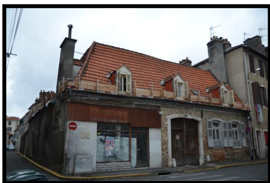
Figure 19 : 20 rue Carreau, avant démolition Source : SIAB
