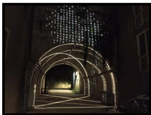
Figure 30 : Eclairage d'un pont au Hédas Source : SIAB
