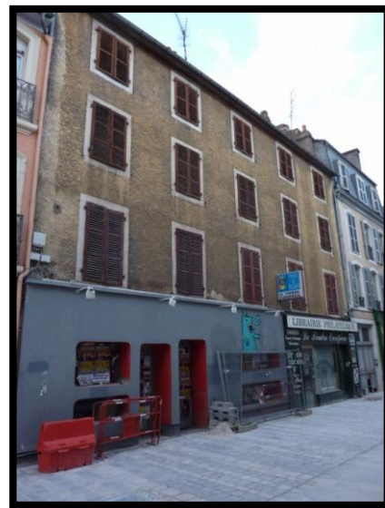
Figure 27 : 5 rue Lamothe avant travaux Source : SIAB
