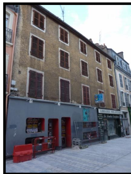
Figure 27 : 5 rue Lamothe avant travaux Source : SIAB
