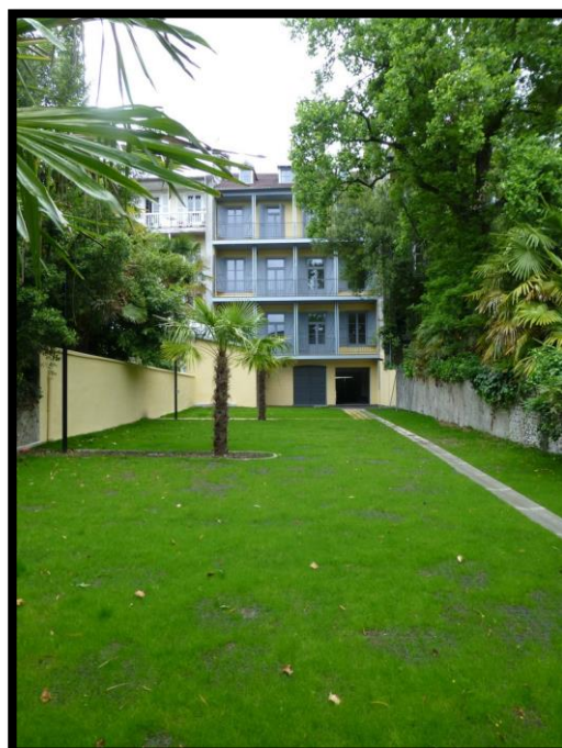
Figure 16 : 49 rue Emile Guichenné après travaux Source : SIAB
