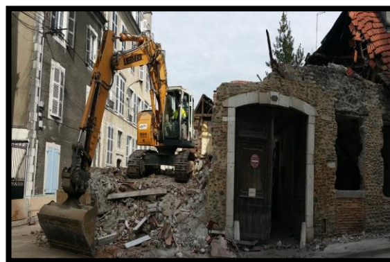
Figure 20 : Démolition du 20 rue Carreau Source : SIAB
