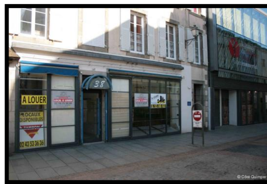
Figure 7 : Vacance commerciale à Quimper Source : Côté Quimper
