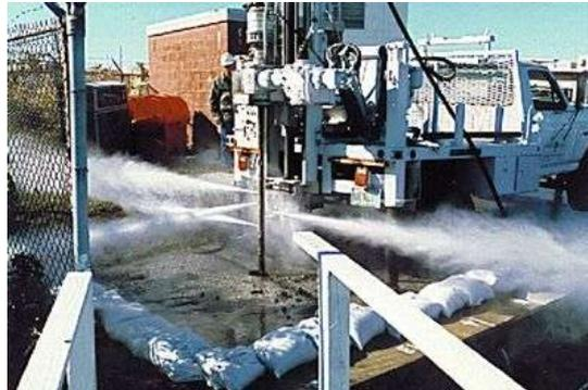
Figure 3.4.4 : Renforcement du terrain par jet grouting.
