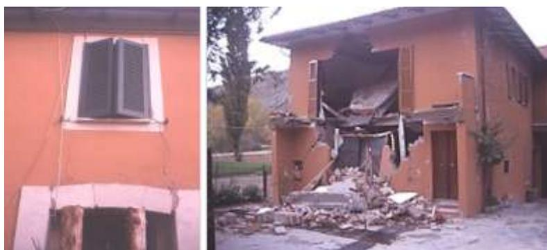
Figure 2.6.7 : Destruction d'une façade causé par des ouvertures.
