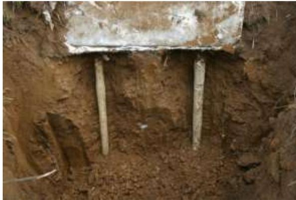
Figure 3.4.7 : Renforcement d'une semelle par micro pieux.
