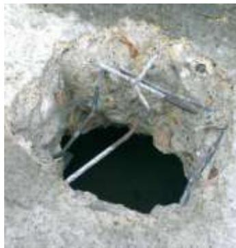
*Figure 2.3.1 : Forage dans une dalle pleine.*
