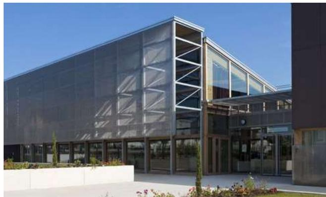
*Figure 3.3.13 : Structure métallique à une diagonale par portique.*
