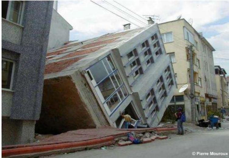
Figure 1.1.5: Destruction d'un bâtiment par tassement dû au séisme.
