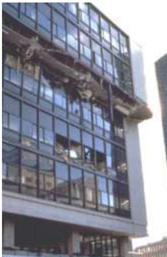
*Figure 1.1.1: Destruction des étages dus à la rotation des planchers.*
