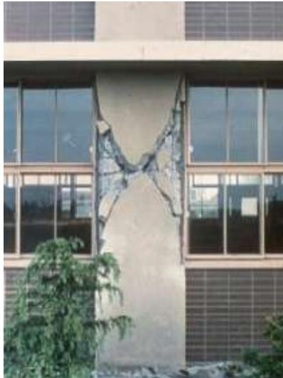
*Figure 1.1.3 : Dégradation du béton autour des ouvertures.*
