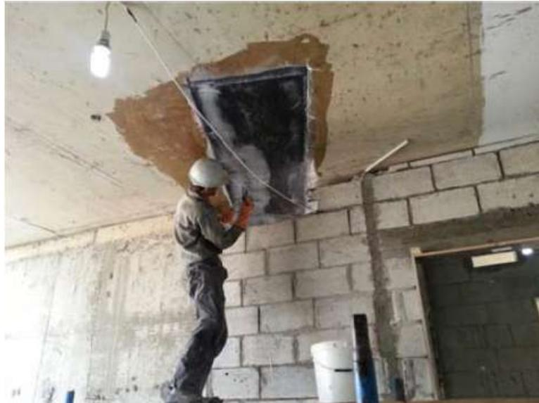
Figure 3.3.25 : Renforcement d'une dalle par PRF.
