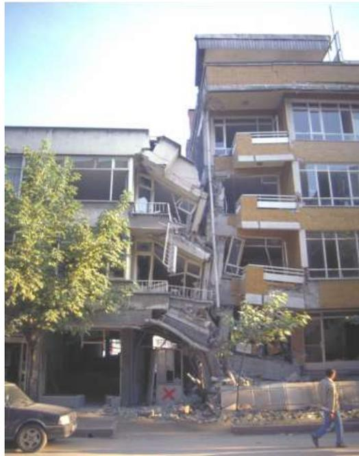
Figure 2.6.8 : Deux bâtiments entrechoqués en l'absence de joints parasismiques.
