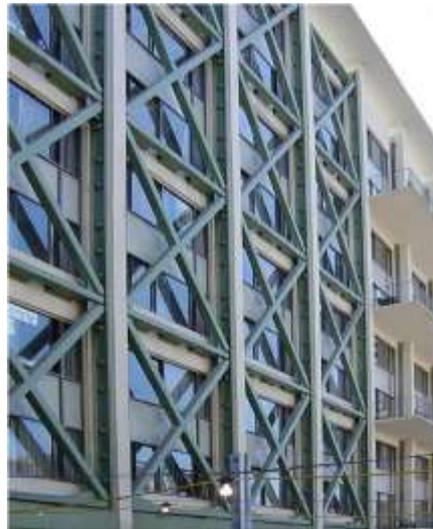
*Figure 3.3.12 : Renforcement par contreventement métallique en X-diagonales.*
