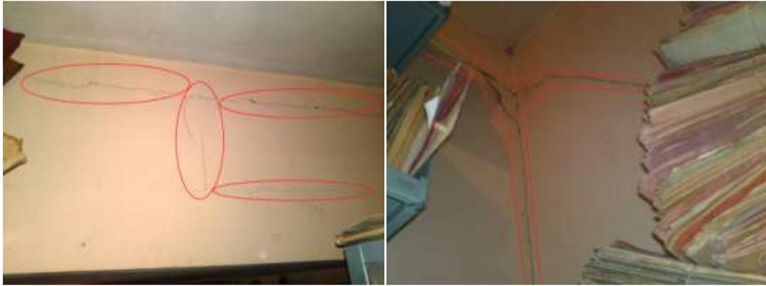
*Figure 5.1.3 : Fissurations dans les murs de remplissages et leurs intersections.*
