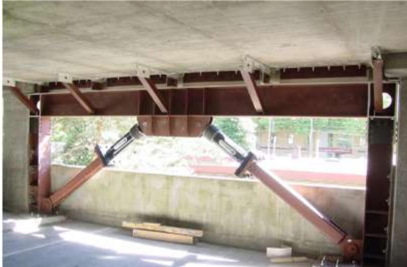
Figure 3.3.9 : Contreventement amortissant au sein d'une structure en béton.
