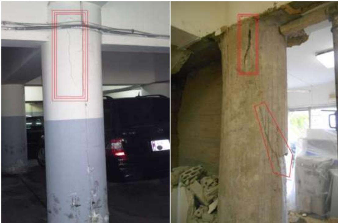
*Figure 5.1.4 : Fissurations apparues sur les poteaux.*
