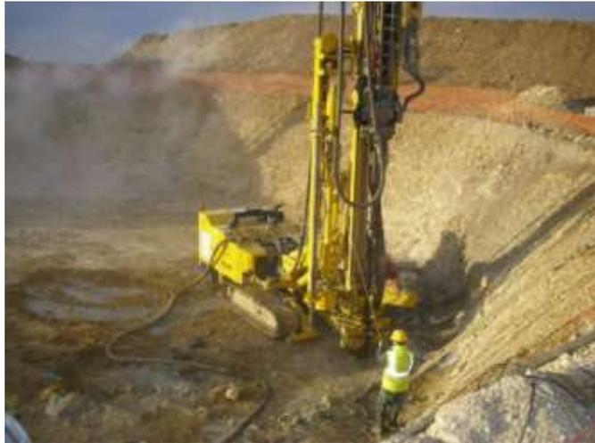
Figure 3.4.5 : Réalisation d'une colonne de CHS.
