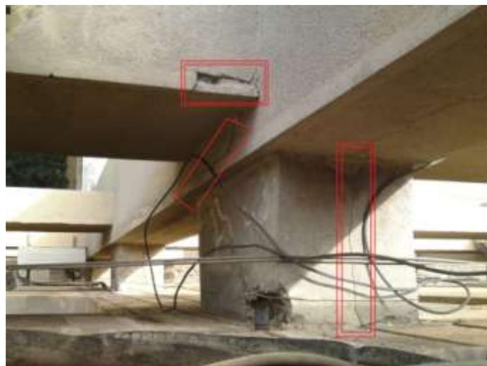
*Figure 5.1.5 : Fissurations apparues sur les poutres.*
