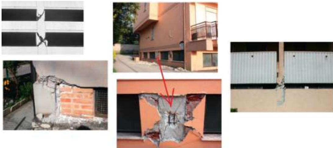
Figure 2.6.6 : Destruction des poteaux courts durant un séisme.
