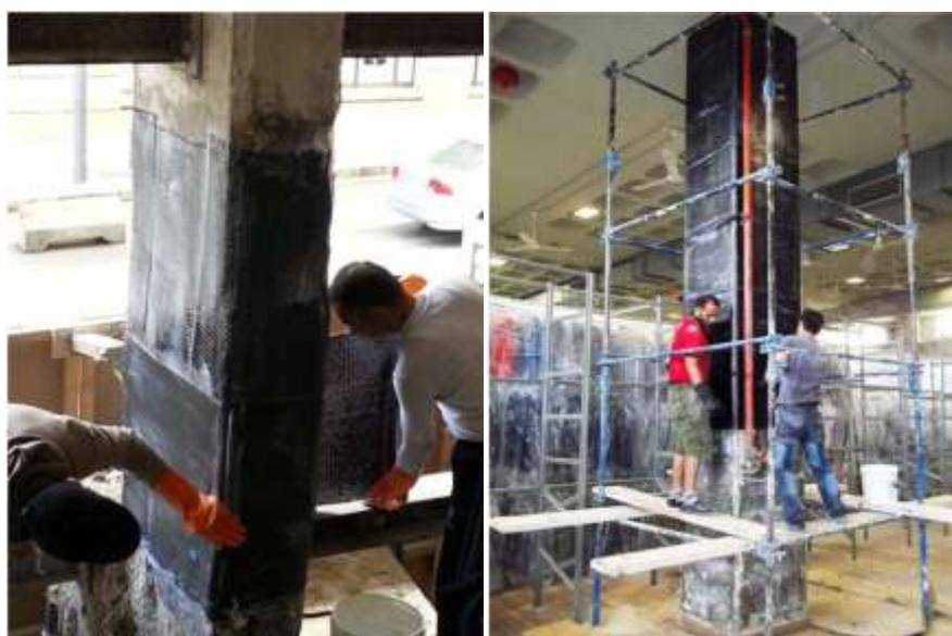
Figure 3.3.22 : Renforts des poteaux par fibres de carbone.
