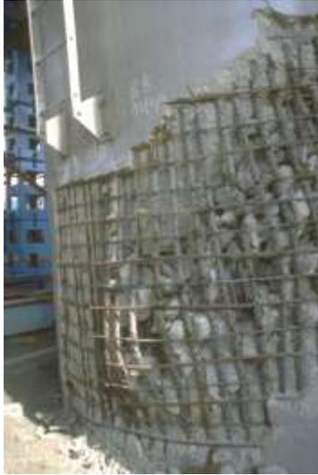
*Figure 1.1.2 : Eclatement du béton en pied du poteau.*
