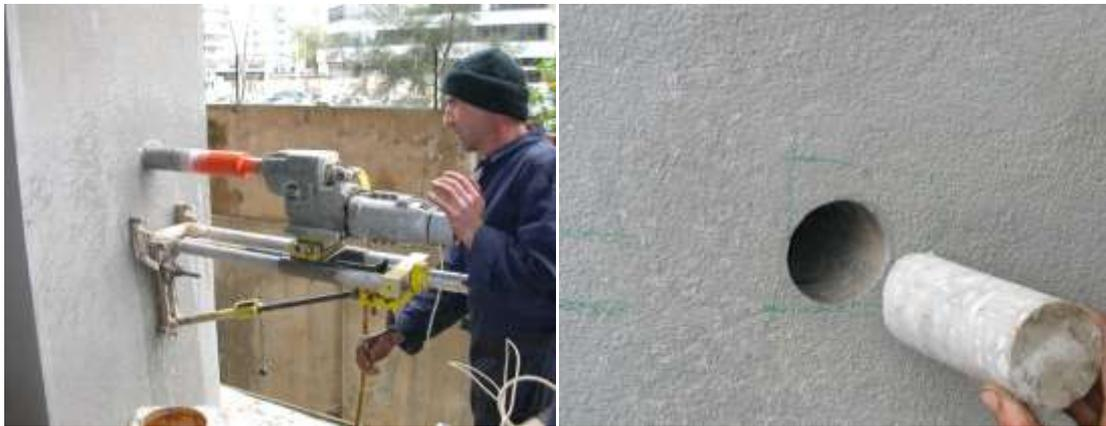
Figure 5.1.6 : Opération de carottage et enlèvement d'un échantillon.
