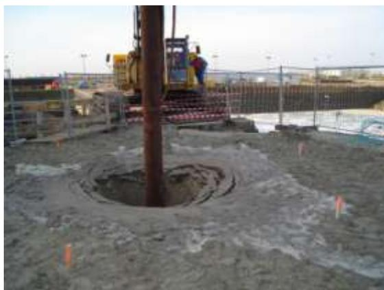
Figure 3.4.8 : Procédé de vibrocompactage d'un sol.
