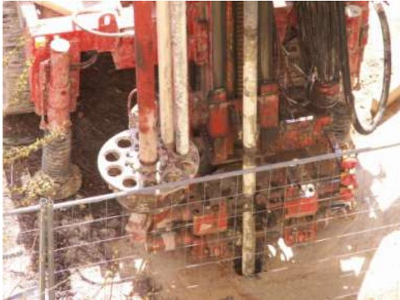
Figure 3.4.3 : Renforcement du sol par forage.
