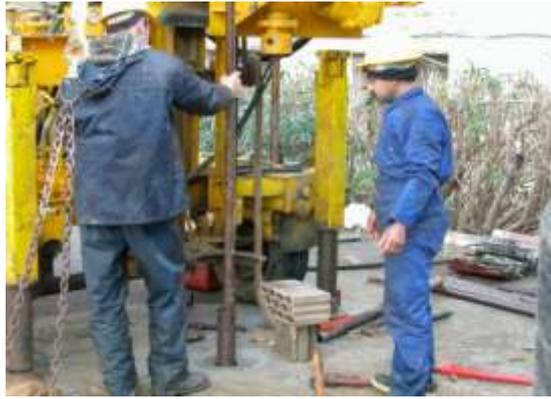
Figure 5.1.10 : Prélèvement d'un échantillon du sol.
