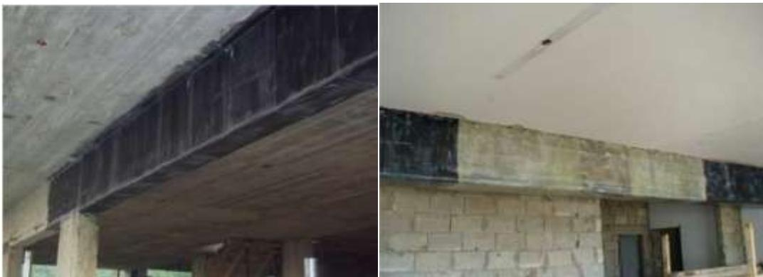
Figure 3.3.23: Renfort des poutres par fibres de carbone.
