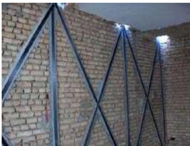
Figure 3.3.17 : Ajout des murs de remplissage incluant deux diagonaux couplés.
