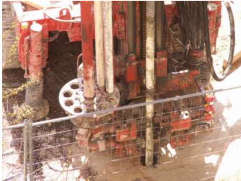
Figure 3.4.3 : Renforcement du sol par forage.
