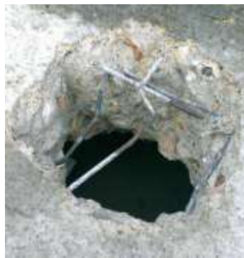
Figure 2.3.1 : Forage dans une dalle pleine.
