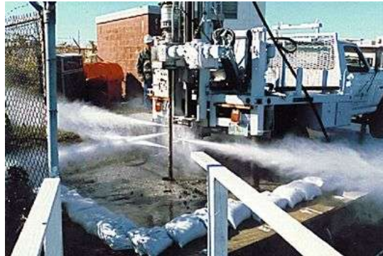
Figure 3.4.4 : Renforcement du terrain par jet grouting.
