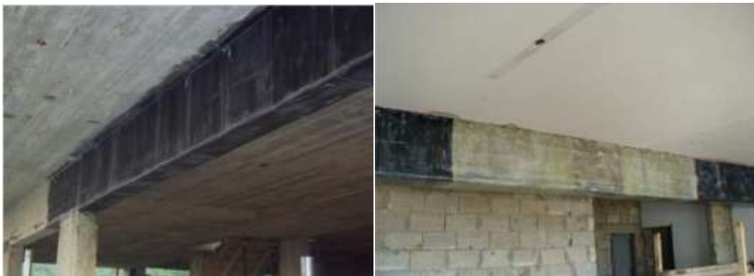
Figure 3.3.23: Renfort des poutres par fibres de carbone.
