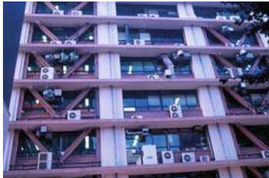
Figure 3.3.10 : Système d'entretoise en V.
