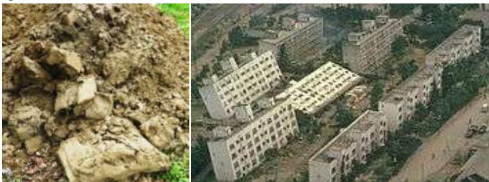
Figure 1.1.6 : Phénomène de liquéfaction et son effet sur les bâtiments.
