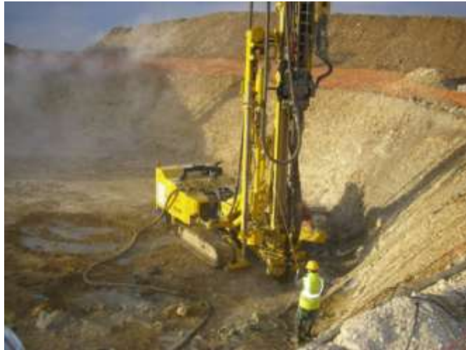
Figure 3.4.5 : Réalisation d'une colonne de CHS.
