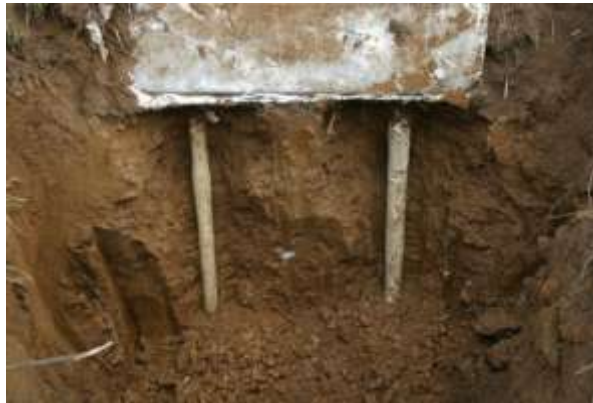
Figure 3.4.7 : Renforcement d'une semelle par micro pieux.
