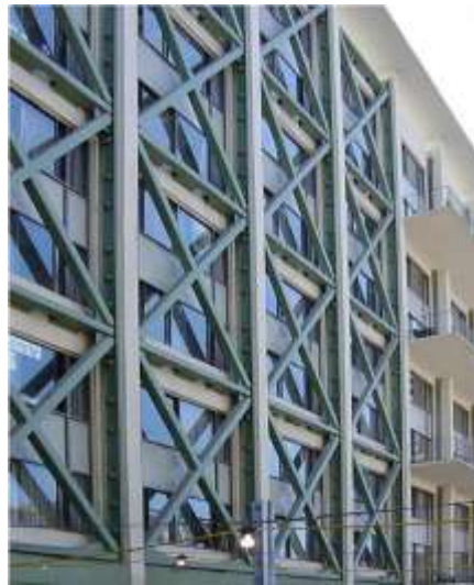
Figure 3.3.12 : Renforcement par contreventement métallique en X-diagonales.
