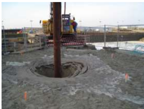
Figure 3.4.8 : Procédé de vibrocompactage d'un sol.
