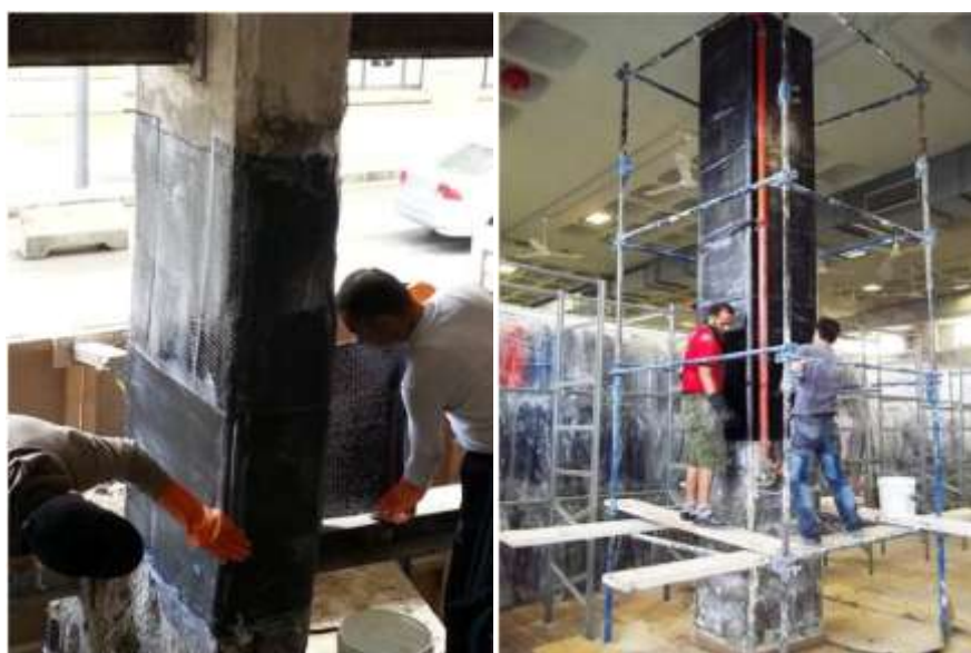
Figure 3.3.22 : Renforts des poteaux par fibres de carbone.
