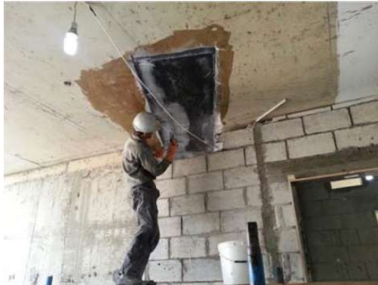
Figure 3.3.25 : Renforcement d'une dalle par PRF.
