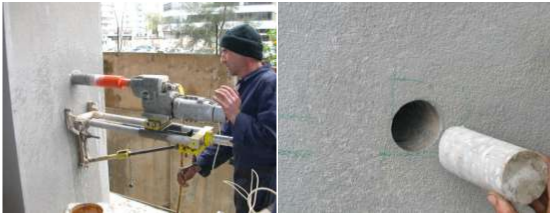
Figure 5.1.6 : Opération de carottage et enlèvement d'un échantillon.
