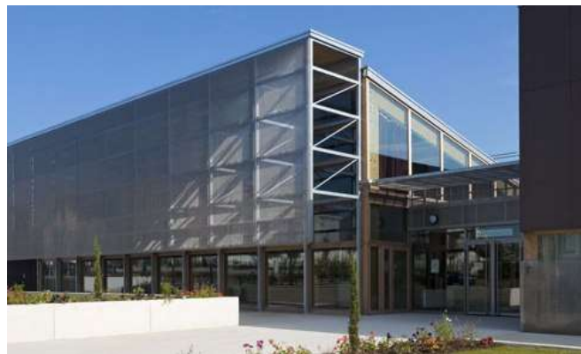
Figure 3.3.13 : Structure métallique à une diagonale par portique.
