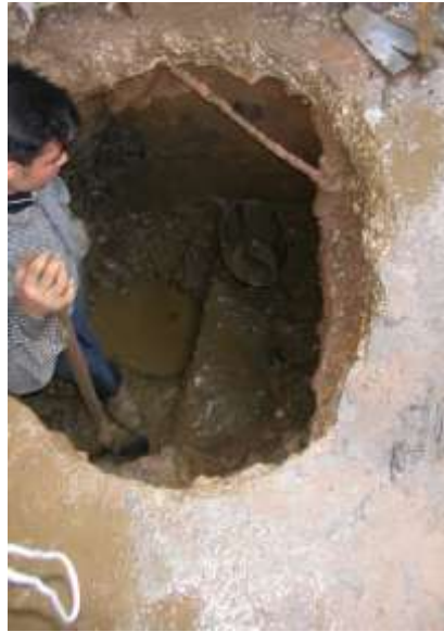
Figure 5.1.8 : Excavation d'une fosse.
