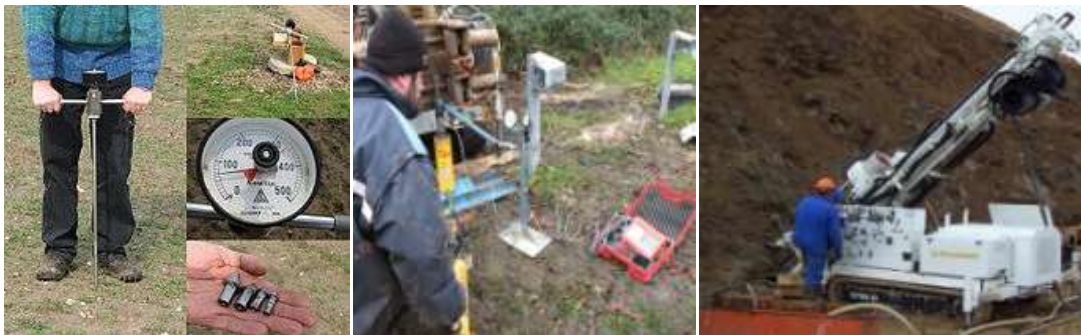
Figure 2.5.2 : Différentes essais du sol sur chantier.
