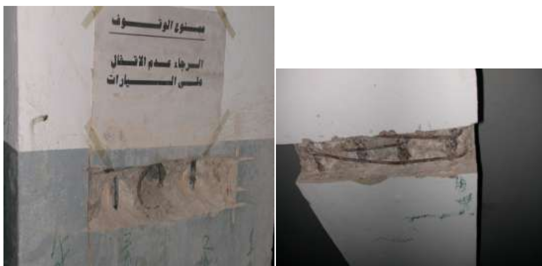
Figure 5.1.7 : Vérification d'armatures de ferrailage d'un poteau (à gauche) et d'une poutre (à droite).
