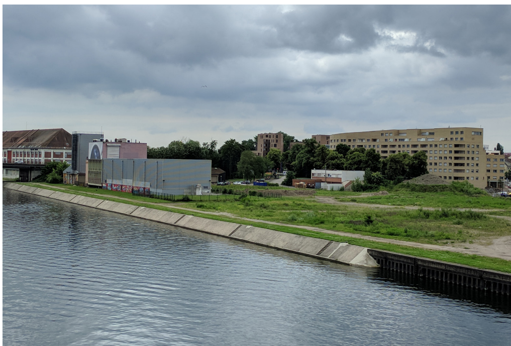
Photographie des quais inclinés vers l'Usine SATI
