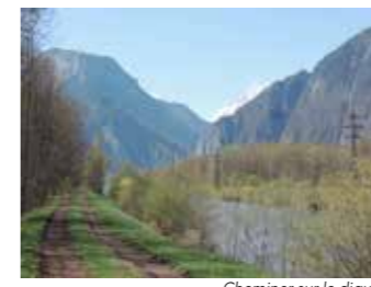
Cheminer sur la digue
