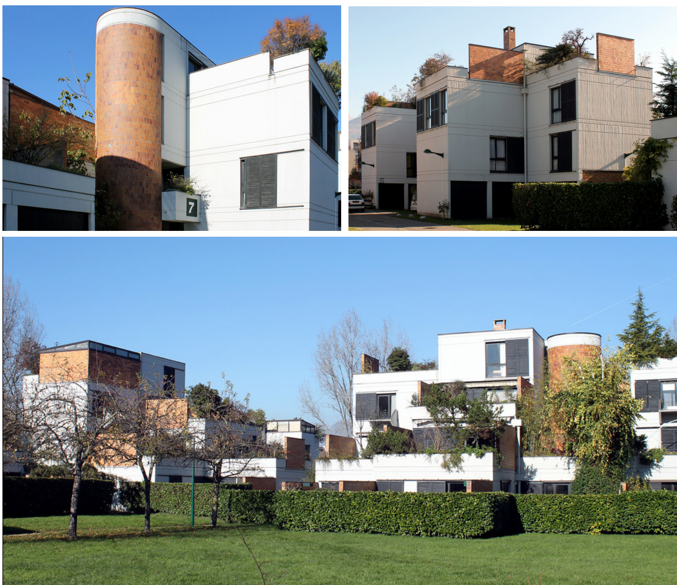
Résidences 2000, Grenoble, Quartier de la Villeneuve, Blanc Maurice (architecte) 1971 © Peter Atkinson
