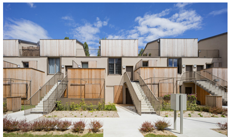
51 logements BBC en accession à la propriété, Sainte-Gene- viève-des-Bois, Essonne (91) 2015 © Crédit photo : Fabienne Gérin-Jean Architectes, ATEC BET – Jean-Michel Rameau Paysagiste. Maître d'ouvrage : NACARAT
