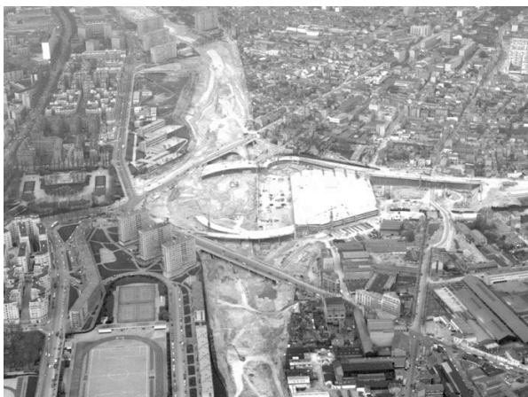
Figure 3 Construction du BP et de l'échangeur de la Porte de Bagnole
